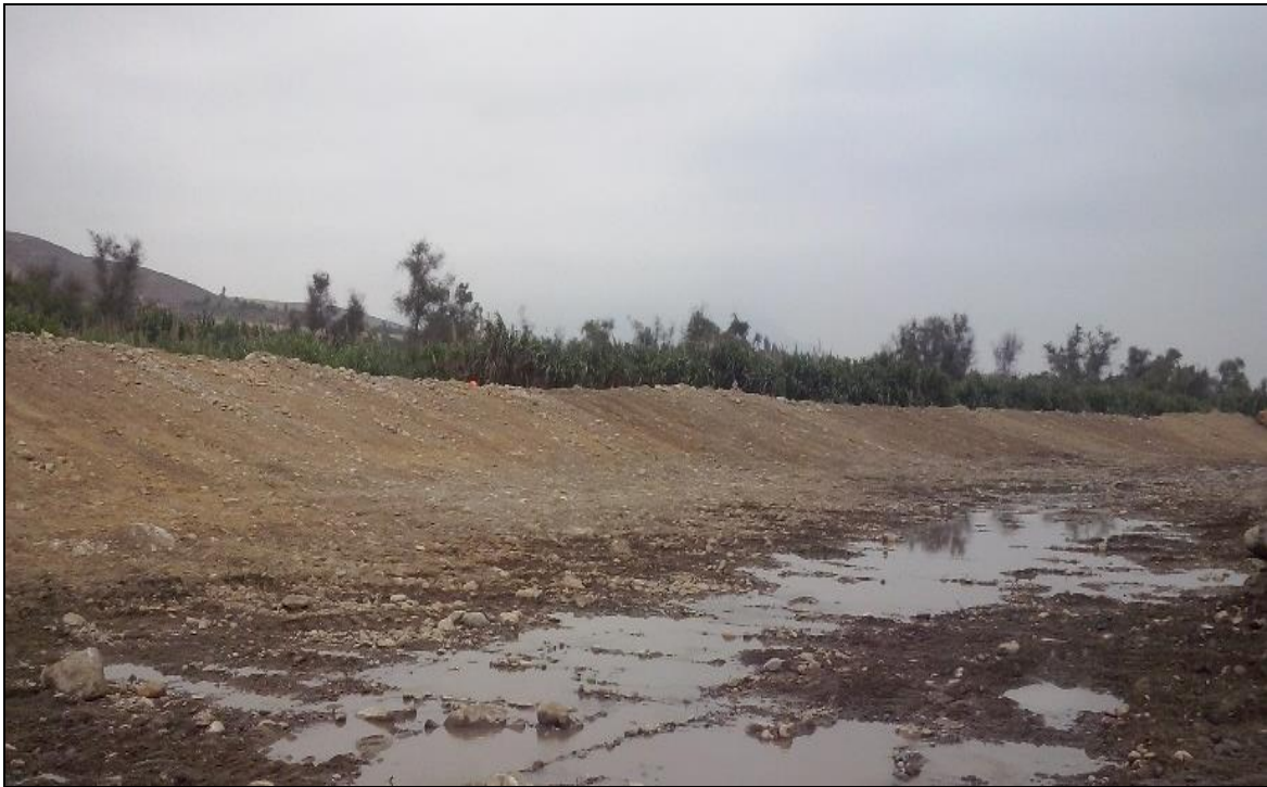
FOTO 43: se muestra una de las actividades de Prevención 2015-2016, Descolmatación de la margen derecha del río Moche, sector Bocatoma La Mochica, Terminado.
