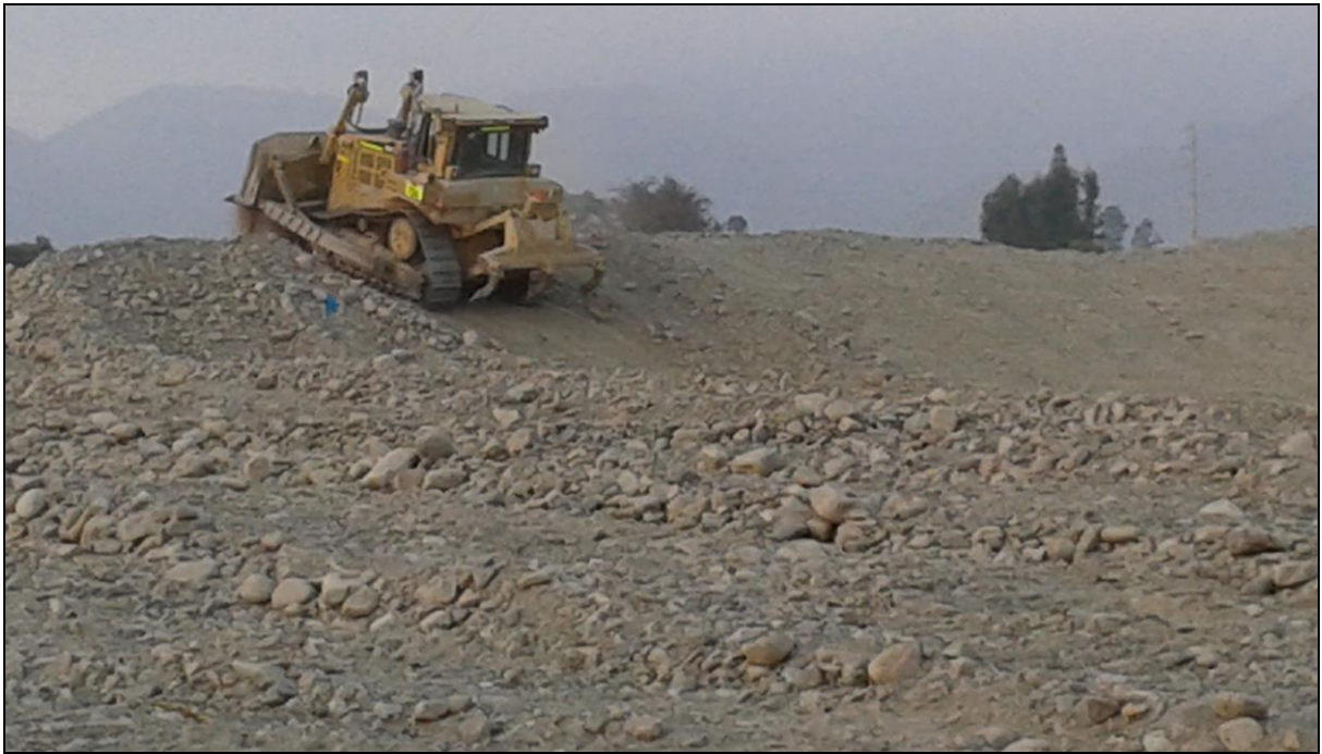
FOTO 17: se muestra una de las actividades de Prevención 2015-2016, Descolmatación del cauce del río Chicama, sector Alayo (Toma Roma) en ejecución.
