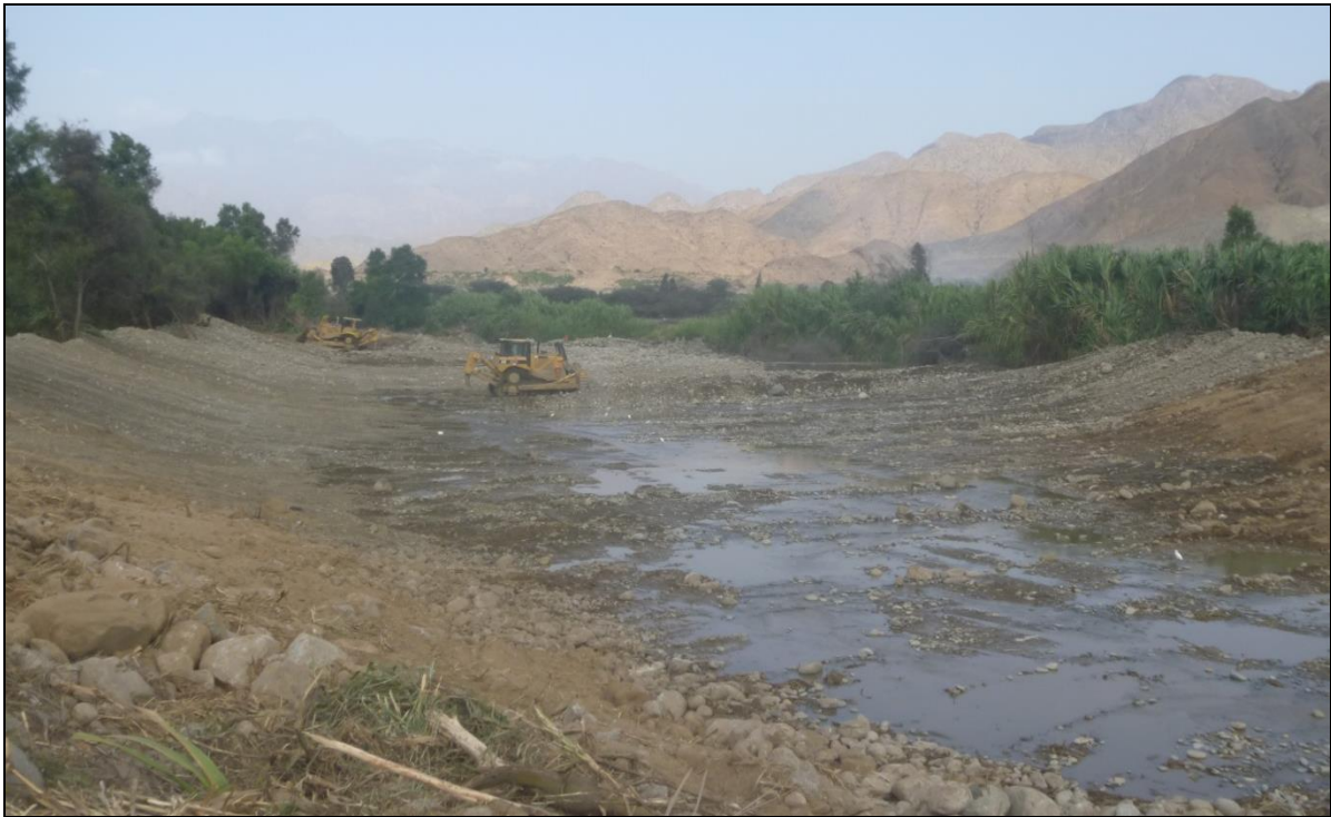
FOTO 41: se muestra una de las actividades de Prevención 2015-2016, Descolmatación y protección de la margen izquierda del río Moche, sector Bocatoma Santo Domingo, en ejecución.
