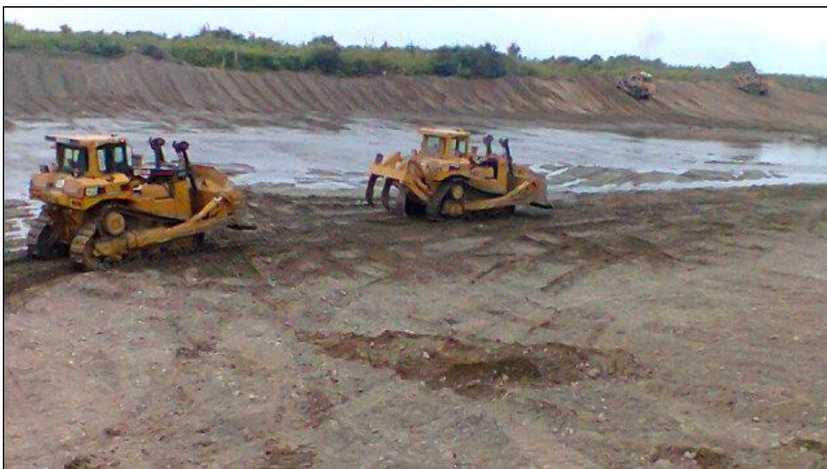
FOTO 40: se muestra una de las actividades de Prevención 2015-2016, Descolmatación protección del río Moche- Sector Curva de Sun - La Bocana - Toma La Bocana, en ejecución.
