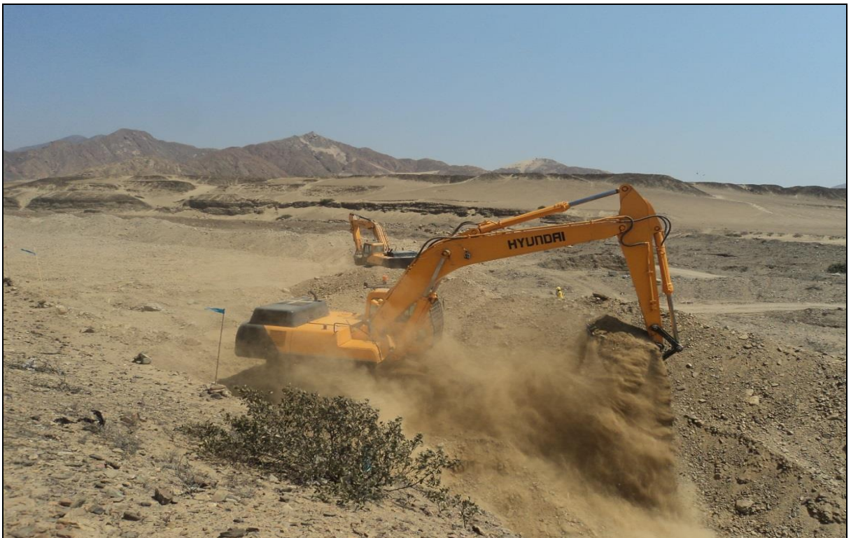
FOTO 10: se muestra una de las actividades de Prevención 2015-2016 en la Quebrada Mal Alma, Parte Alta, en ejecución.
