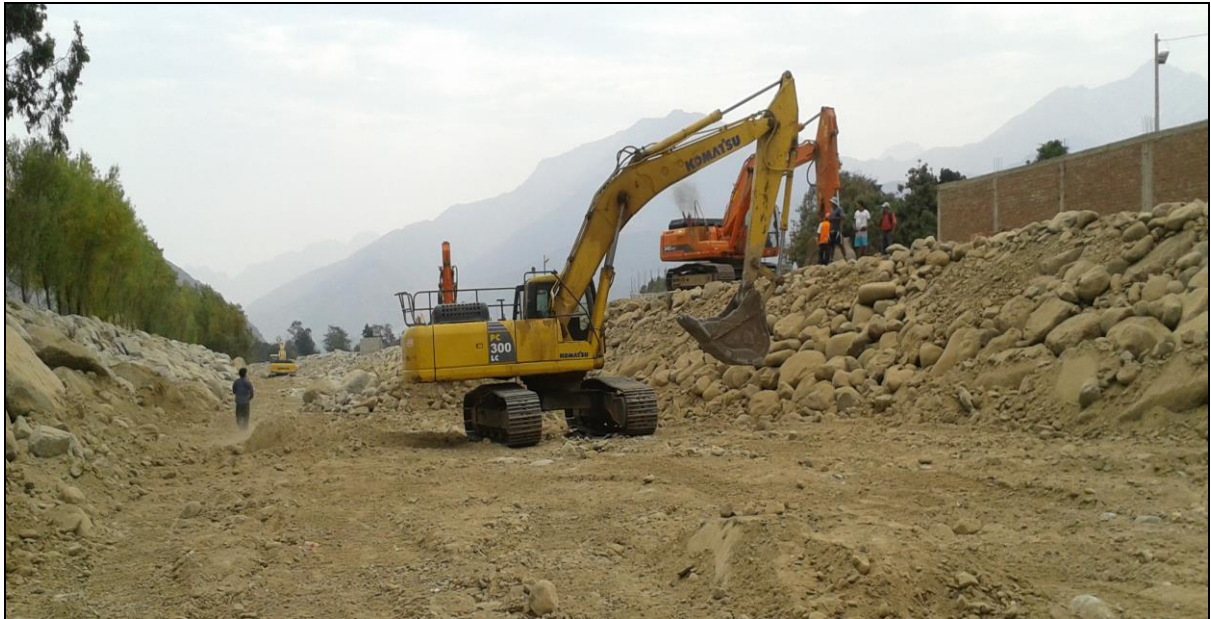
FOTO 37: se muestra una de las actividades de Prevención 2015-2016 en río Pedregal-Simbal, en ejecución.
