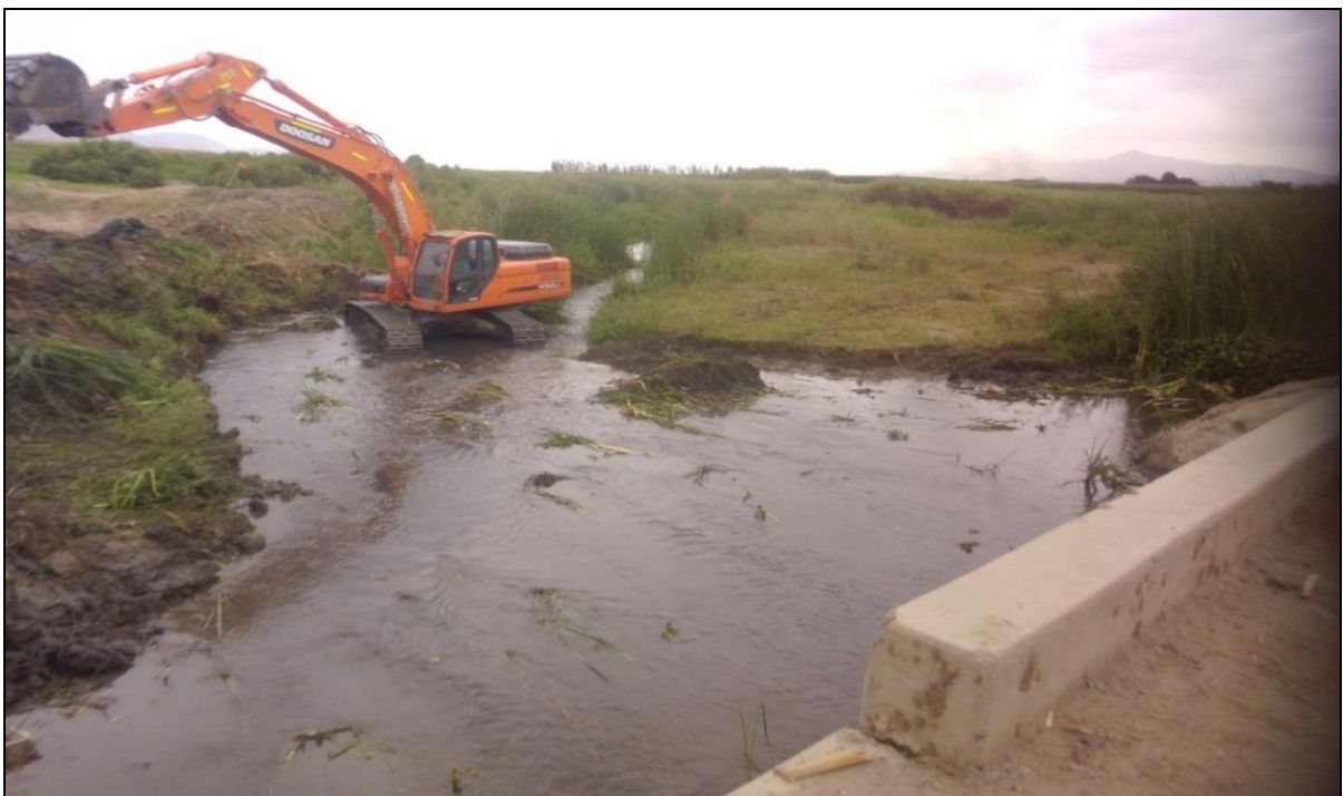
FOTO 34: se muestra una de las actividades de Prevención 2015-2016, Descolmatación y Encausamiento del río Chorobal, sector el Tizal, en ejecución.
