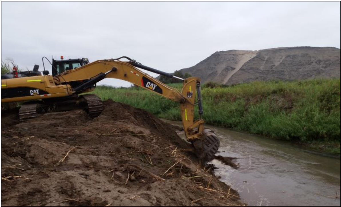
FOTO 35: se muestra una de las actividades de Prevención 2015-2016, roca al volteo en el río Chao, sector Laramie, en ejecución.
