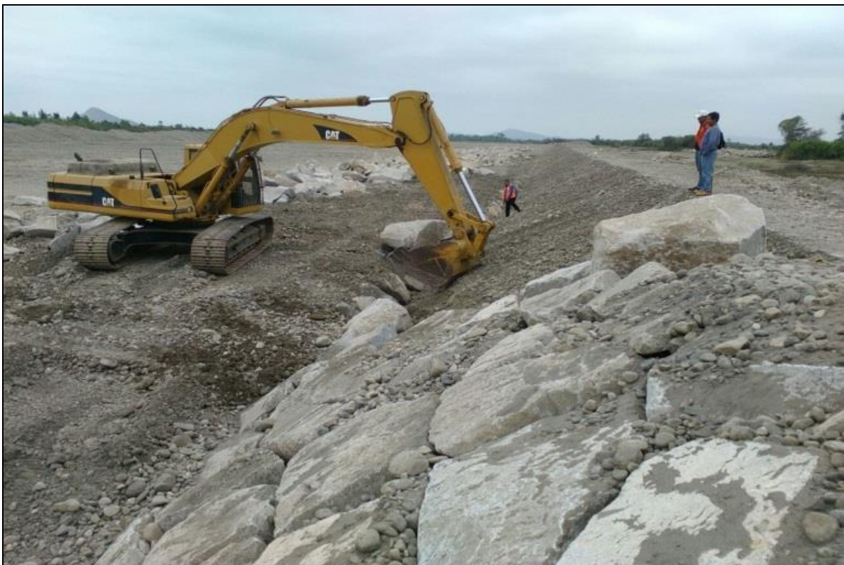
FOTO 20: se muestra una de las actividades de Prevención 2015-2016 en río Chicama, sector Alayo, en ejecución (solo falta la colocación de la roca acomodada)
