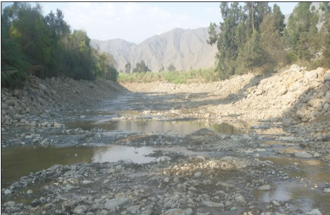
FOTO 44: se muestra una de las actividades de Prevención 2015-2016, Descolmatación de la margen derecha del río Moche, sector Santa Rosa Baja, Terminado.
