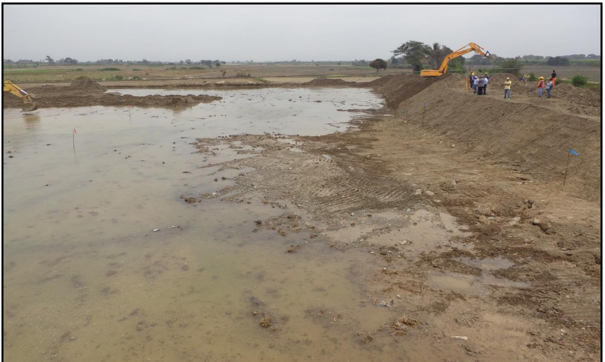
FOTO 06: se muestra una de las actividades de Prevención 2015-2016 en río Chaman, sector Puente Panamericana, terminado.
