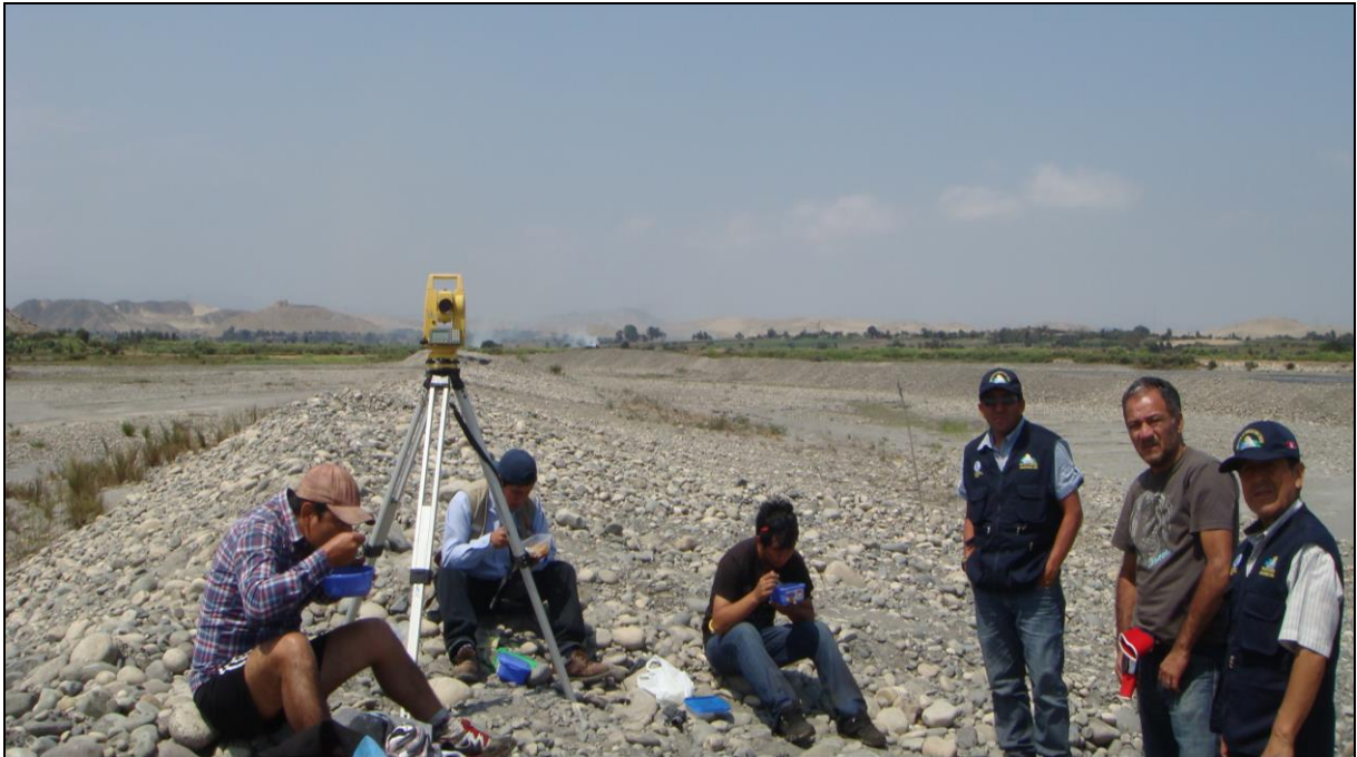
FOTO 21: se muestra una de las actividades de Prevención 2015-2016 en río Santa, sector Pueblo Nuevo en ejecución
