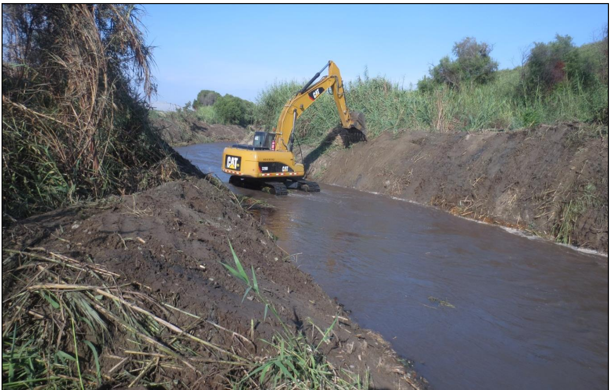
FOTO 36: se muestra una de las actividades de Prevención 2015-2016, Descolmatación y Encausamiento del río Chao, sector las delicias, en ejecución.
