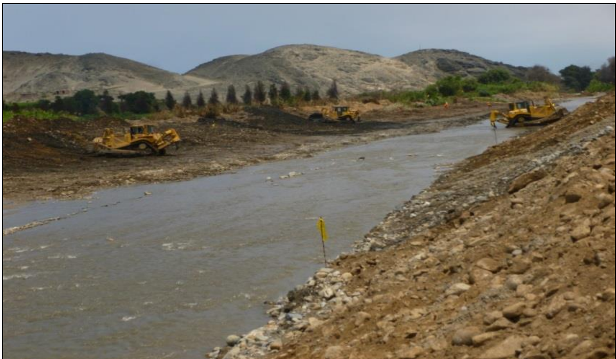
FOTO 38: se muestra una de las actividades de Prevención 2015-2016, Descolmatación protección del río Moche M.I., sector Puente Moche - Laguna de Estabilización Curva Sun - Toma Arenal Sánchez (Santa Lucía), en ejecución.
