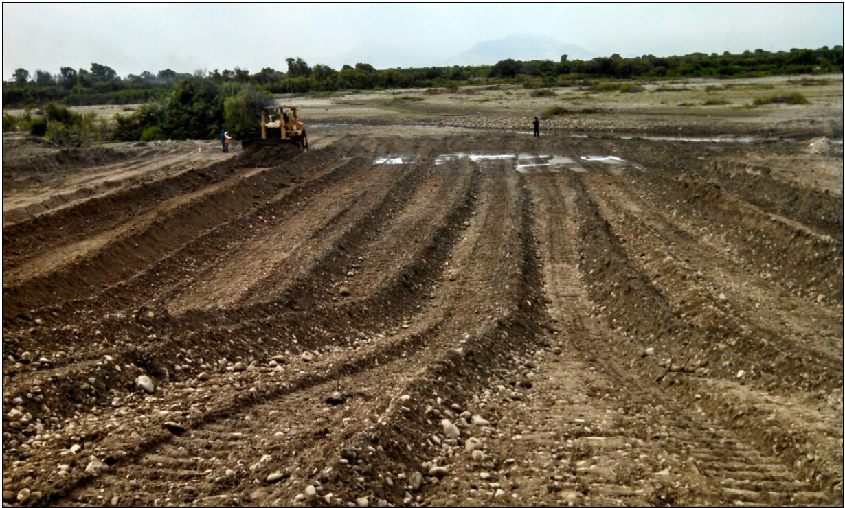
FOTO 15: se muestra una de las actividades de Prevención 2015-2016 en río Chicama, sector Toma Vallejo, en ejecución.
