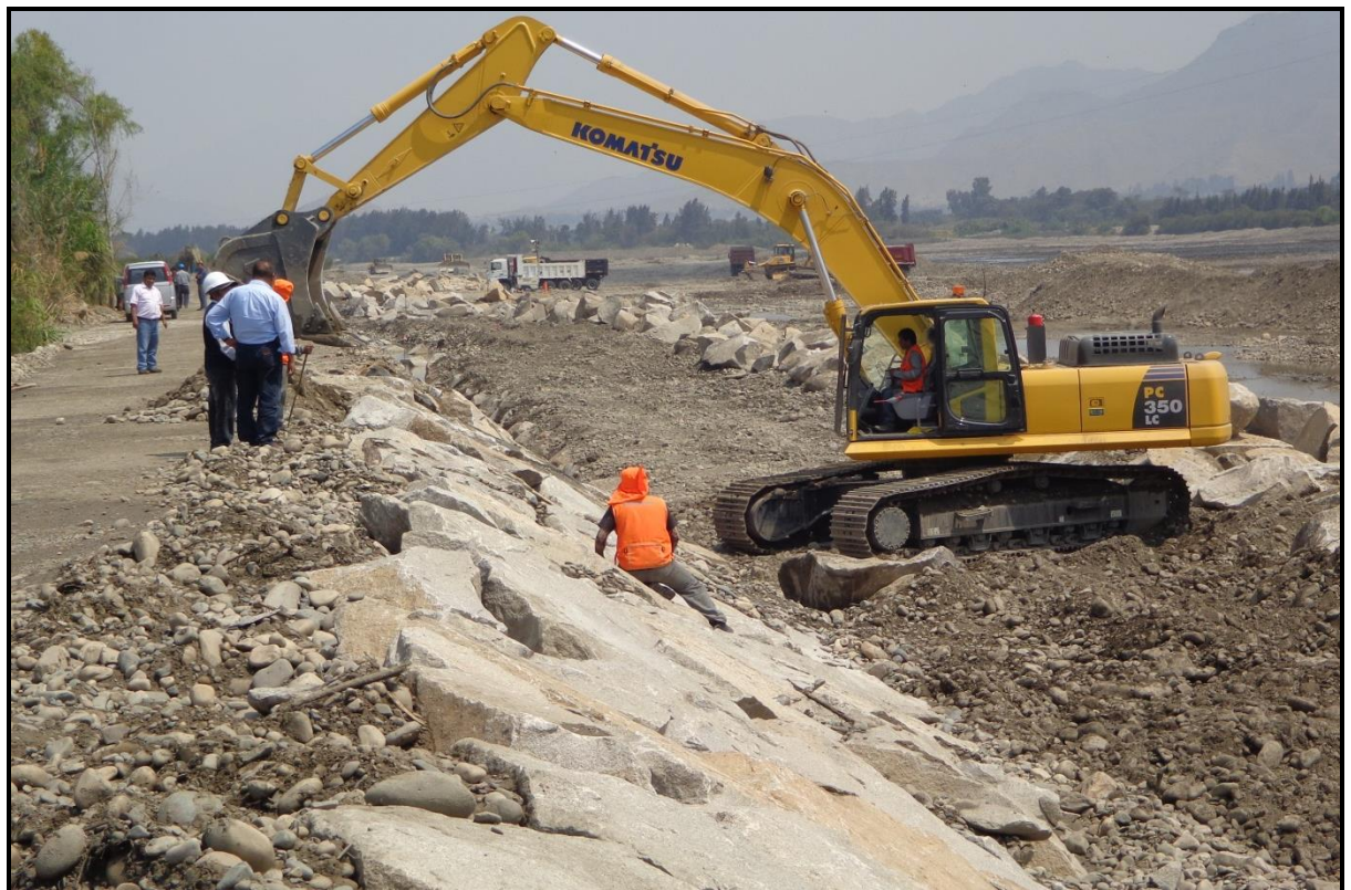
FOTO 12: se muestra una de las actividades de Prevención 2015-2016, Descolmatación y Protección de la margen izquierda del río Chicama, sector Voladero, durante su ejecución (terminado)
