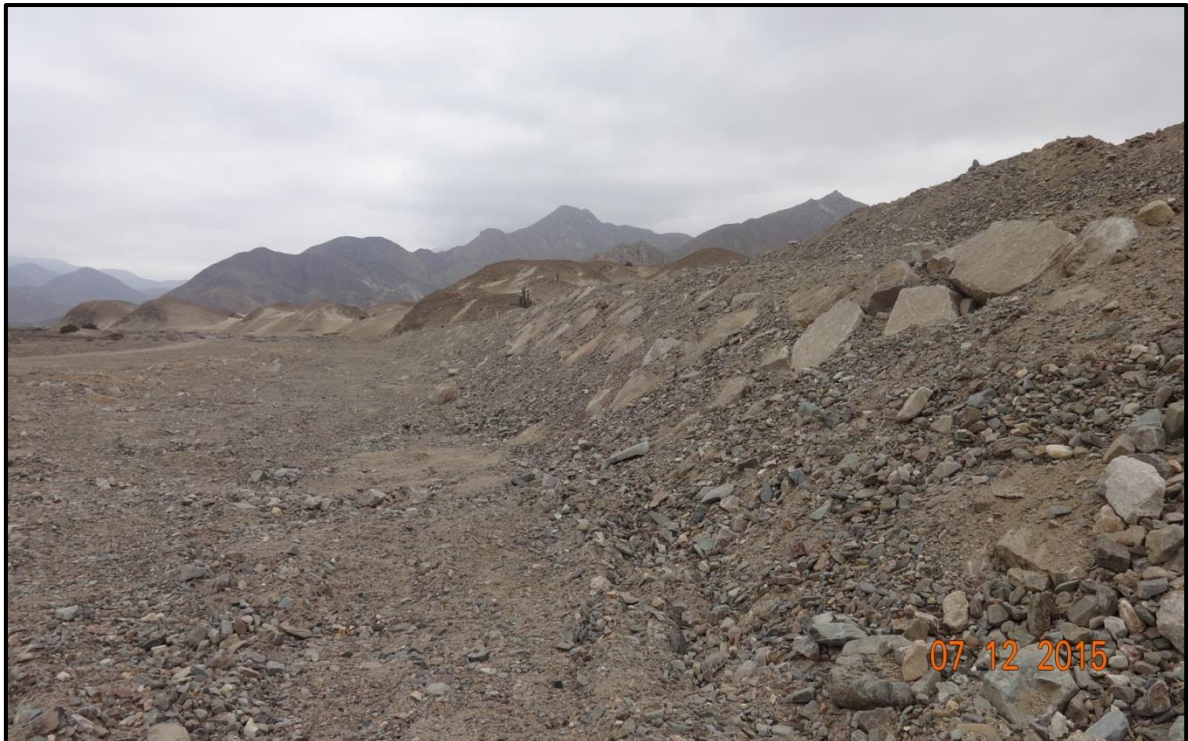
FOTO 66: se muestra una de las actividades de Prevención 2015-2016 Adicional I Paquete, Protección con roca al volteo de la quebrada mal Alma, sector Sausal, Terminado.
