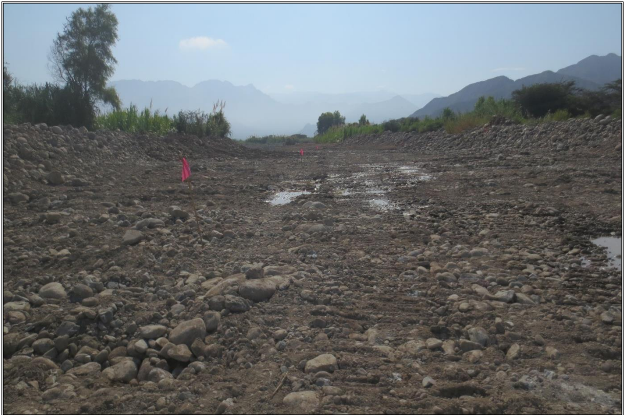
FOTO 23: se muestra una de las actividades de Prevención 2015-2016 en río Virú, Sector Vinzos, Terminado
