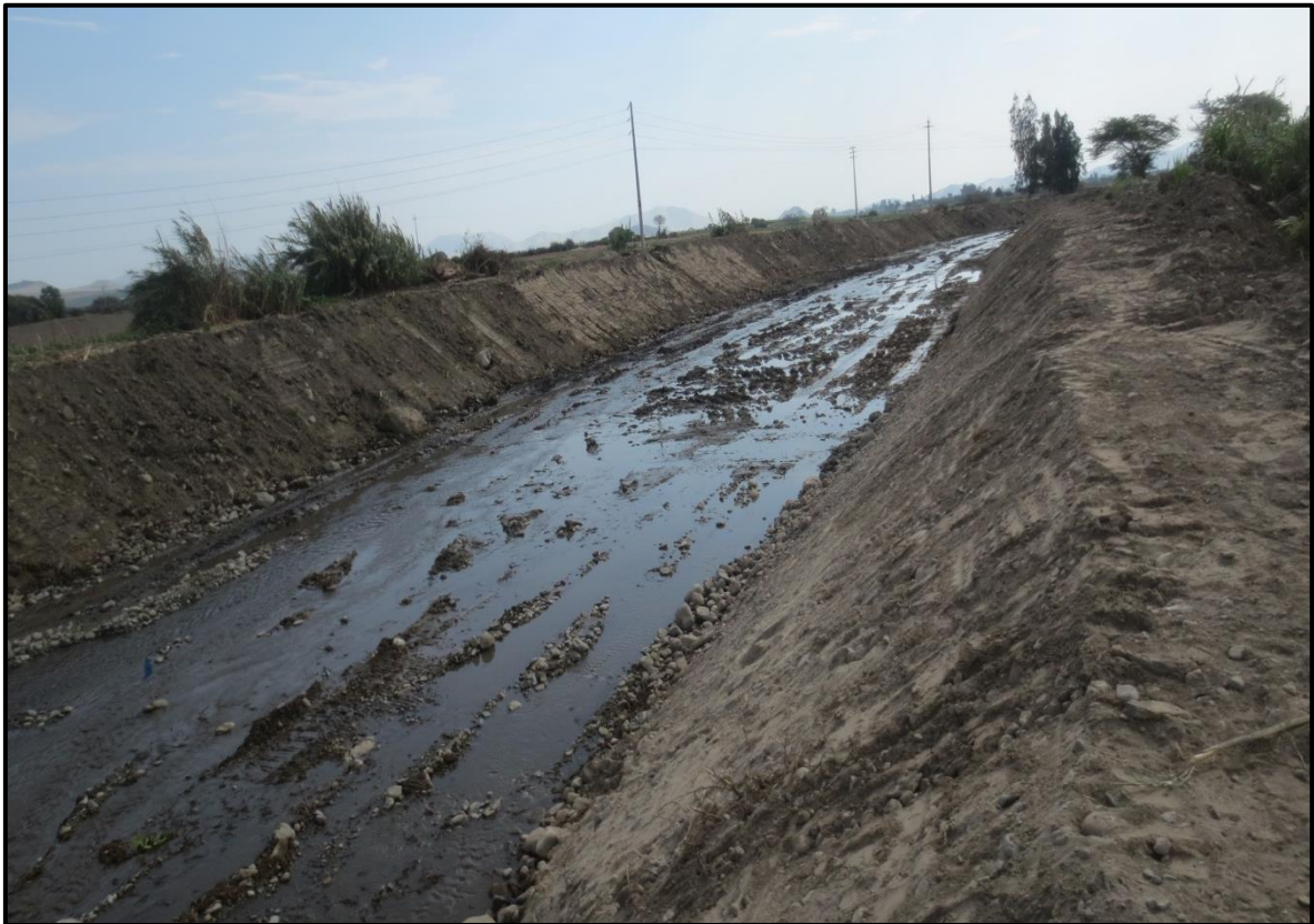
FOTO 59: se muestra una de las actividades de Prevención 2015-2016 III Paquete, Descolmatación y Encauzamiento del Río Huamanzaña, Sector Palermo., Terminado.
