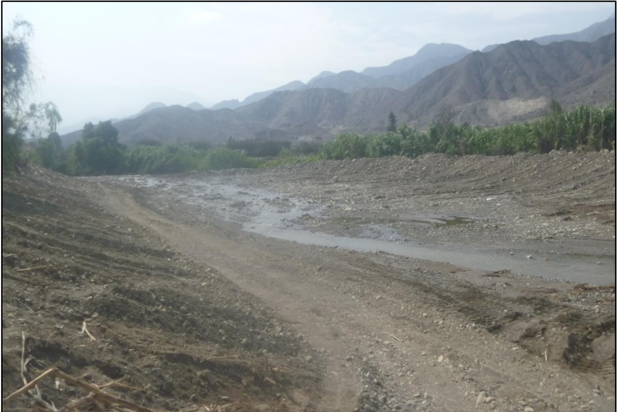
FOTO 41: se muestra una de las actividades de Prevención 2015-2016, Descolmatación y protección de la margen izquierda del río Moche, sector Bocatoma Santo Domingo, Terminado.
