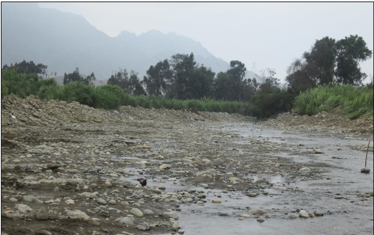
FOTO 42: se muestra una de las actividades de Prevención 2015-2016, Descolmatación de la margen Izquierda del río Moche, sector Bocatoma Huatape, Terminado.
