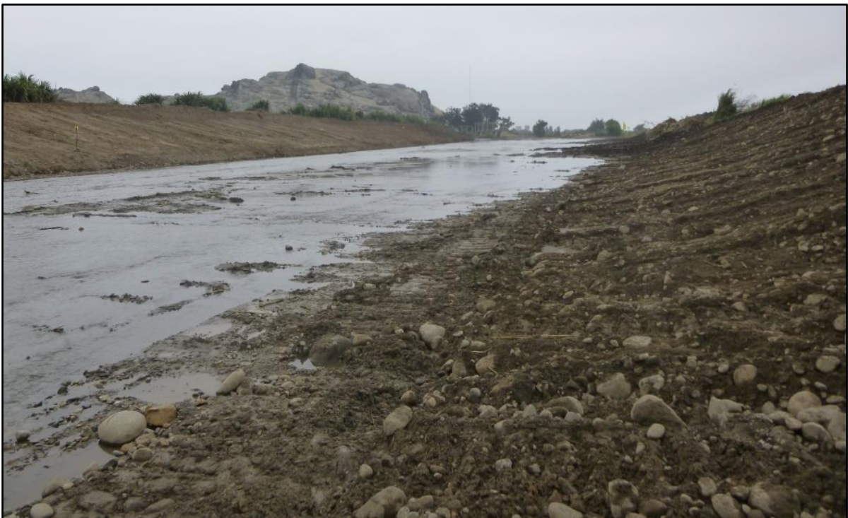
FOTO 40: se muestra una de las actividades de Prevención 2015-2016, Descolmatación protección del río Moche- Sector Curva de Sun - La Bocana - Toma La Bocana, Terminado.
