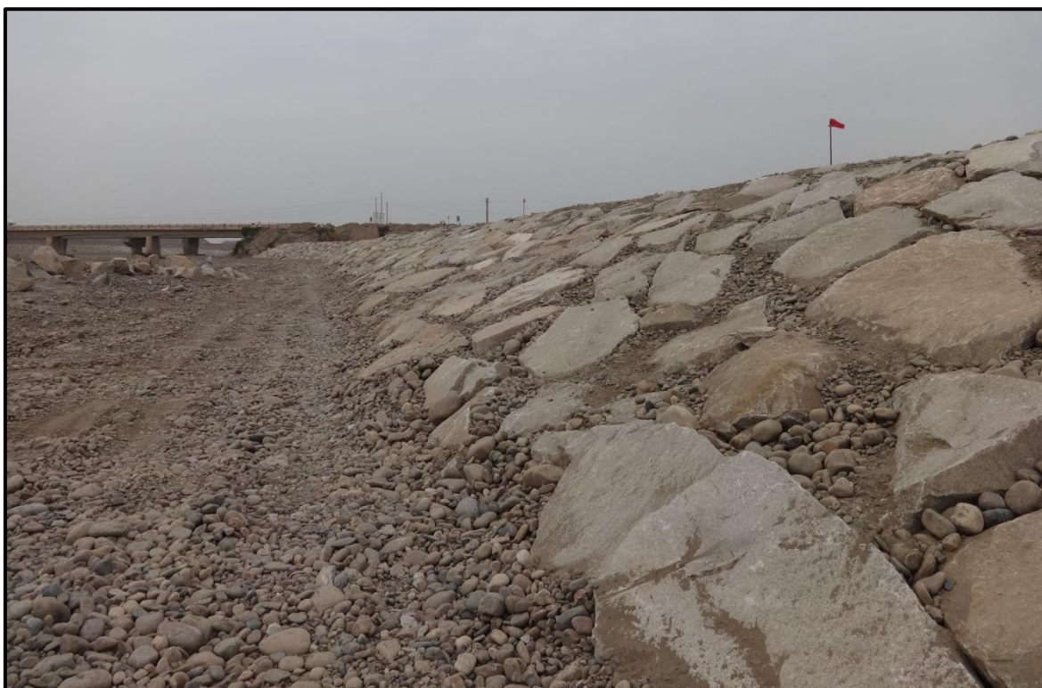
FOTO 56: se muestra una de las actividades de Prevención 2015-2016 III Paquete, Descolmatación del Río Chicama Aguas Arriba del Puente Careaga, terminado.
