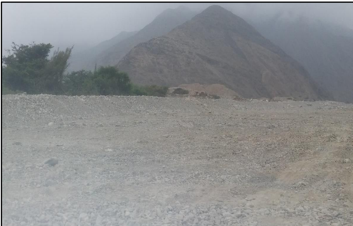
FOTO 60: se muestra una de las actividades de Prevención 2015-2016 Adicional I Paquete, Descolmatación y Protección de la margen derecha de la quebrada Caracol, Terminado.
