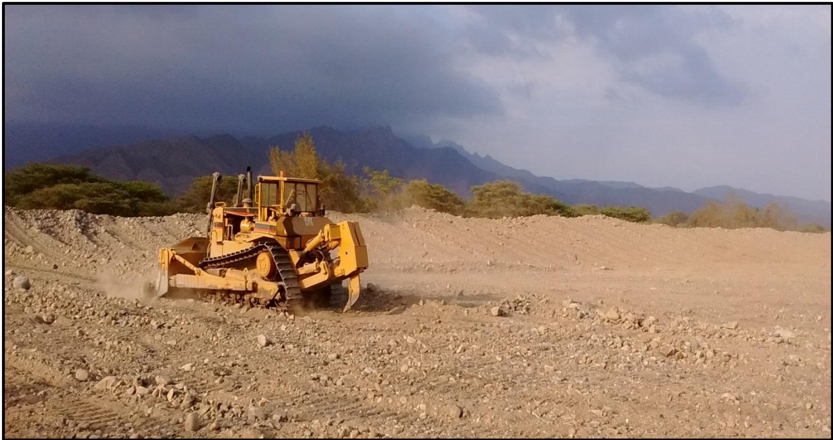
FOTO 63: se muestra una de las actividades de Prevención 2015-2016 Adicional I Paquete, Limpieza y Descolmatación del cauce del río Chaman, Sector La Cataluña, Distrito de Pacanga - Chepen- la Libertad, Terminado.
