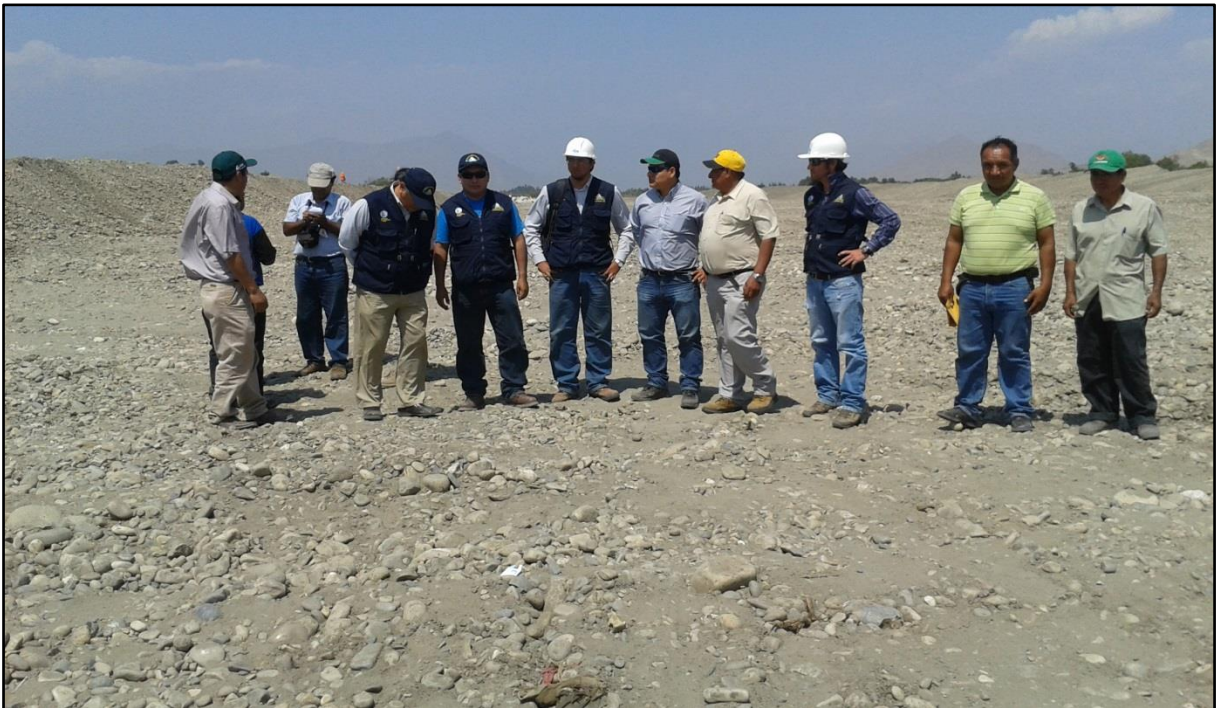
FOTO 16: se muestra una de las actividades de Prevención 2015-2016, Descolmatación del cauce del río Chicama, sector Alayo (Toma Roma), Terminado.
