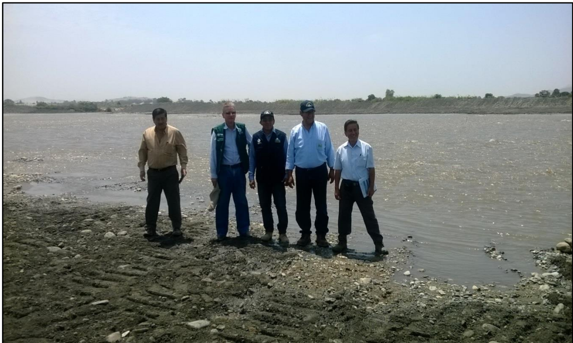
FOTO 20: se muestra una de las actividades de Prevención 2015-2016 en río Santa, sector Pueblo Nuevo en ejecución
