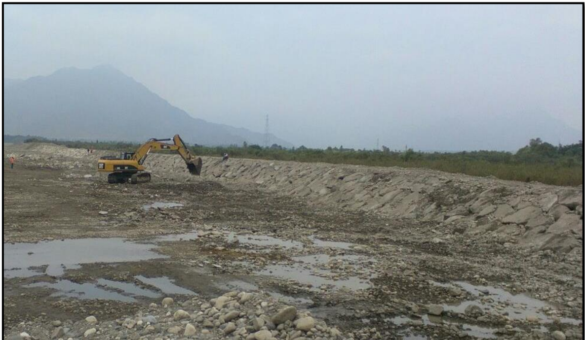
FOTO 18: se muestra una de las actividades de Prevención 2015-2016 en río Chicama, sector Atahualpa, en Terminado
