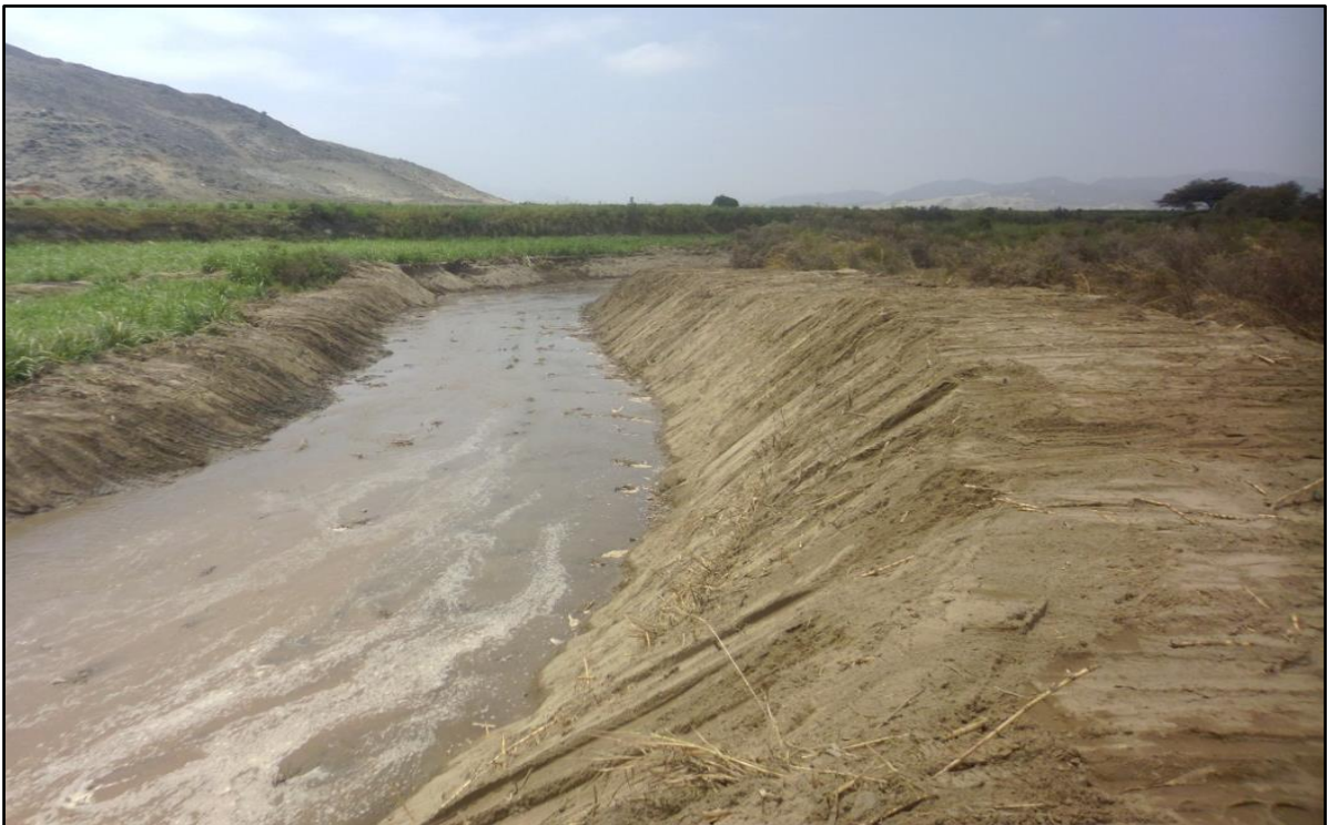
FOTO 34: se muestra una de las actividades de Prevención 2015-2016, Descolmatación y Encausamiento del rio Chorobal, sector el Tizal, Terminado.
