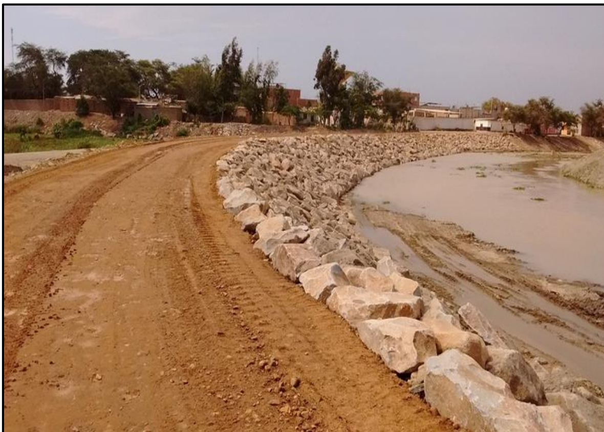
FOTO 55: se muestra una de las actividades de Prevención 2015-2016 III Paquete, Protección con Roca al Volteo, Margen Izquierda del Río Chaman, Sector Pueblo Nuevo, Terminado.
