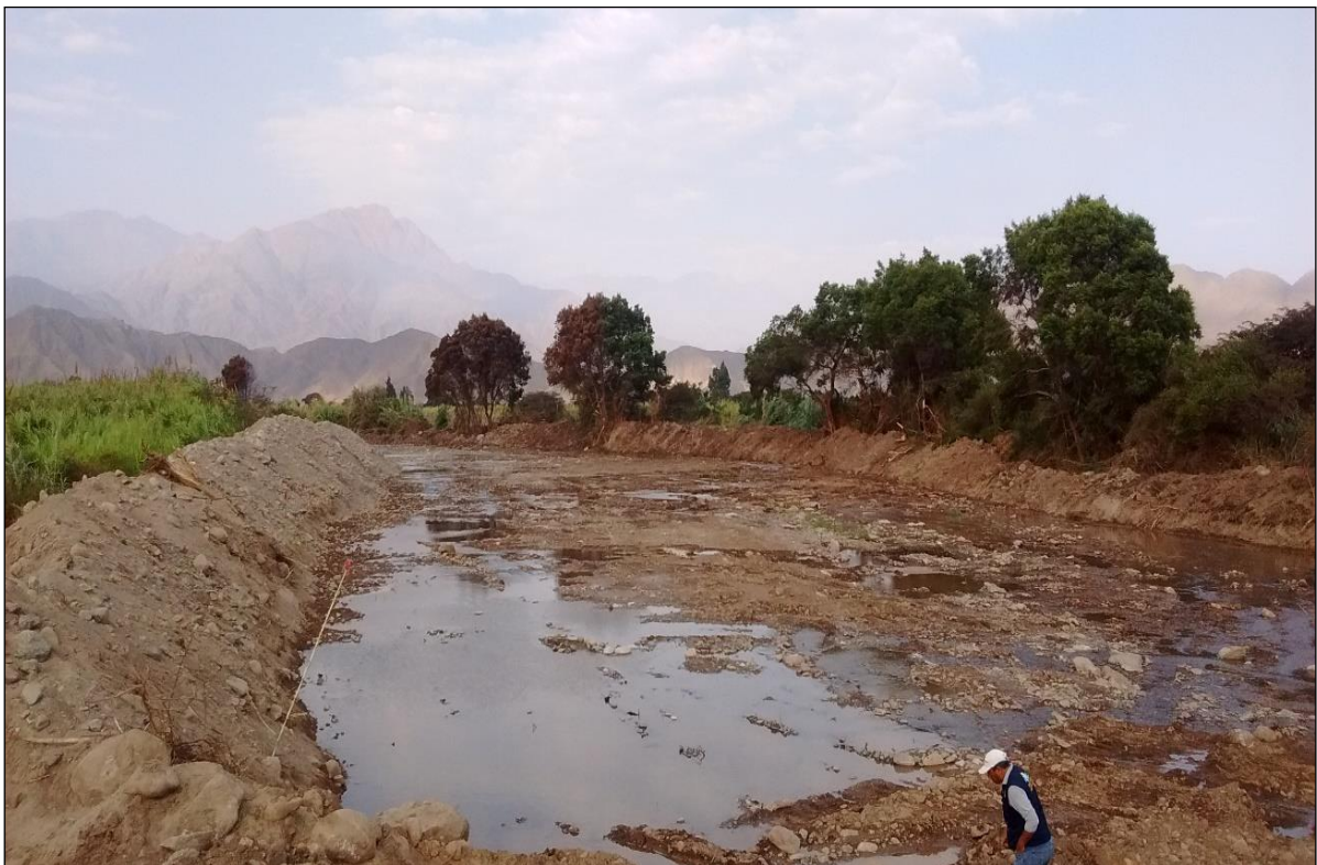
FOTO 28: se muestra una de las actividades de Prevención 2015-2016 en río Virú, tramo San Idefonso, Sector la Gloria, Terminado.
