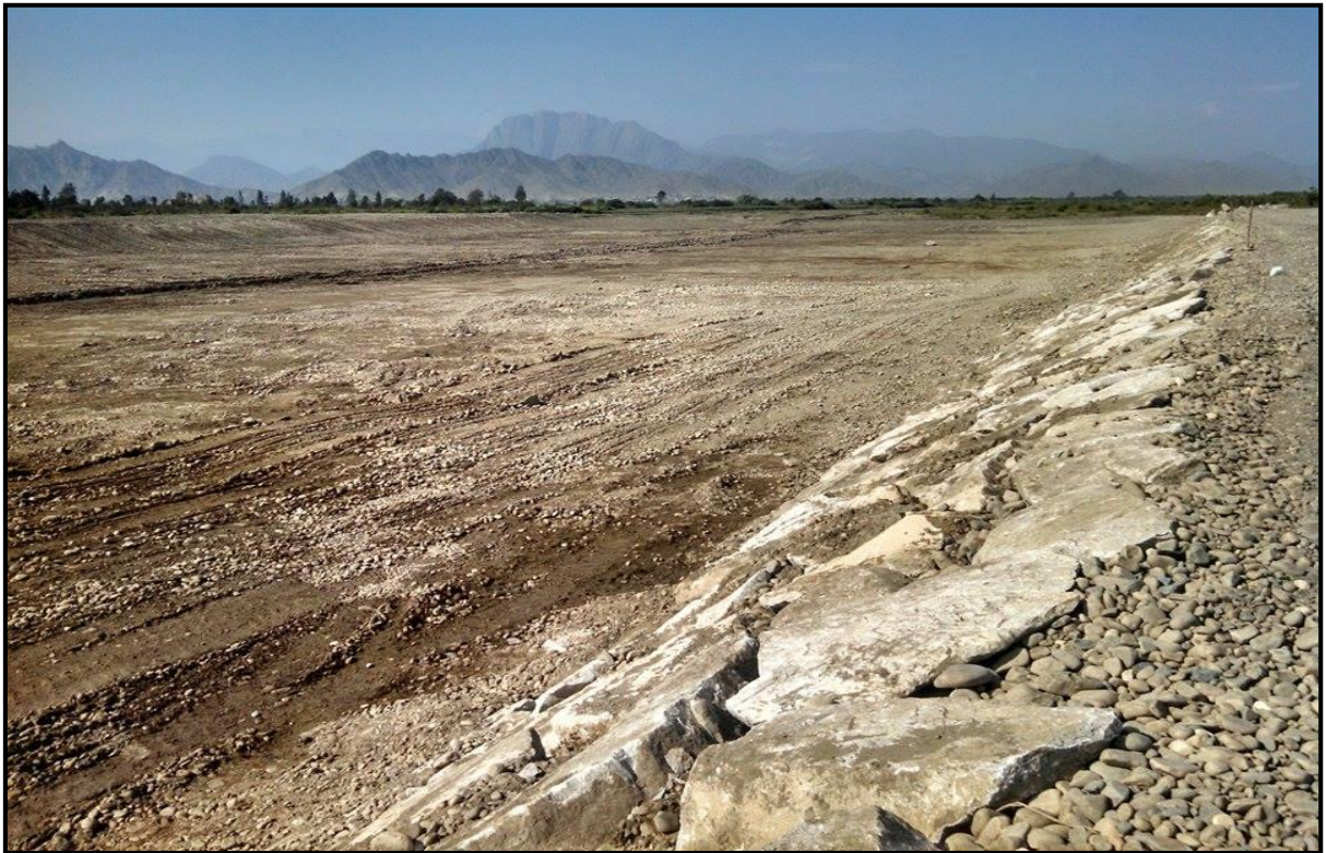
FOTO 17: se muestra una de las actividades de Prevención 2015-2016 en río Chicama, sector Cañal, terminado.
