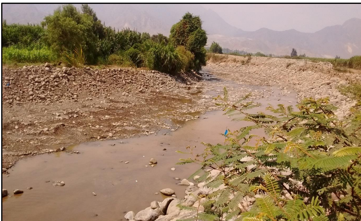
FOTO 44: se muestra una de las actividades de Prevención 2015-2016, Descolmatación de la margen derecha del río Moche, sector Bocatoma Moro-Vichanzao, Terminado.
