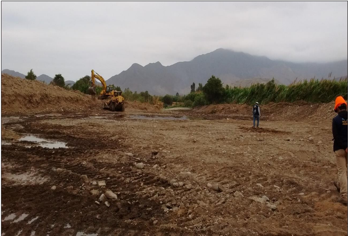
FOTO 27: se muestra una de las actividades de Prevención 2015-2016 en río Virú, tramo Pompillo Cotrina, Sector San Nicolás, Terminado.
