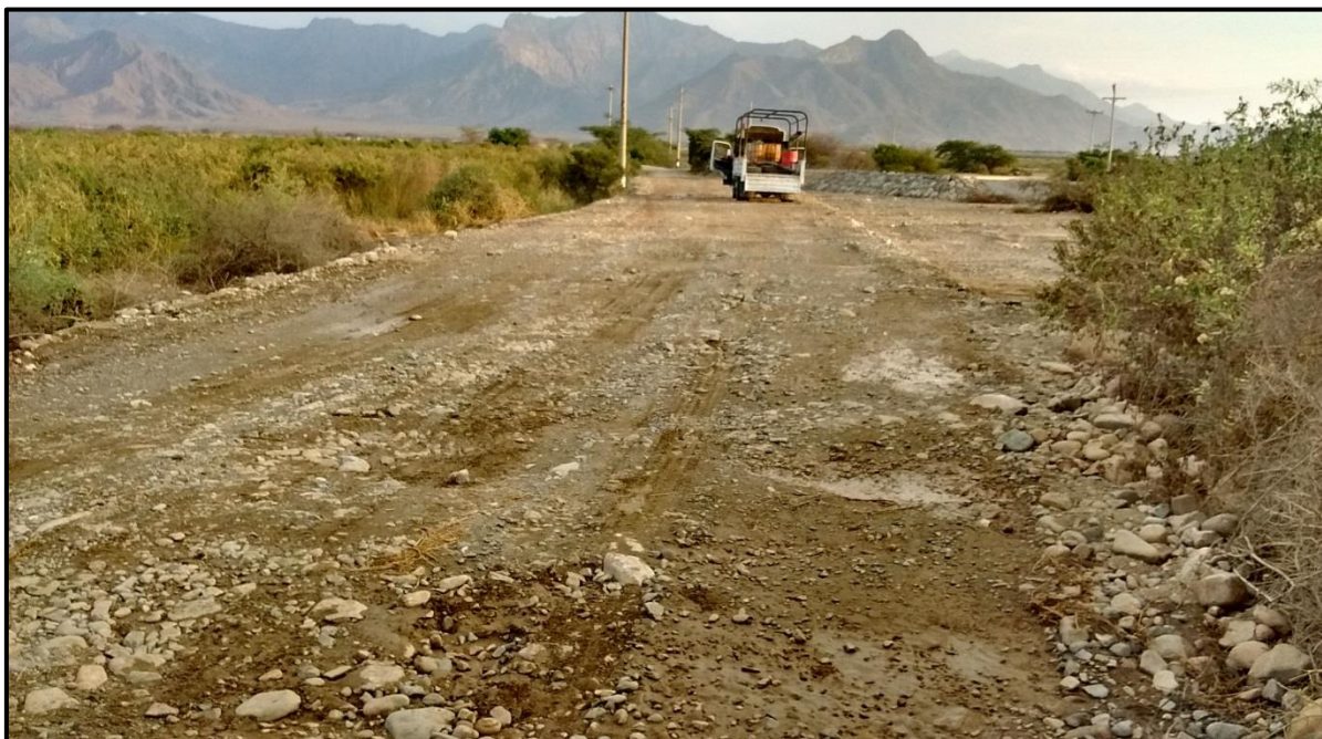
FOTO 61: se muestra una de las actividades de Prevención 2015-2016 Adicional I Paquete, Defensa Margen Derecha Canal Talambo Zaña Km: 6+834 - 24+552, Terminado.
