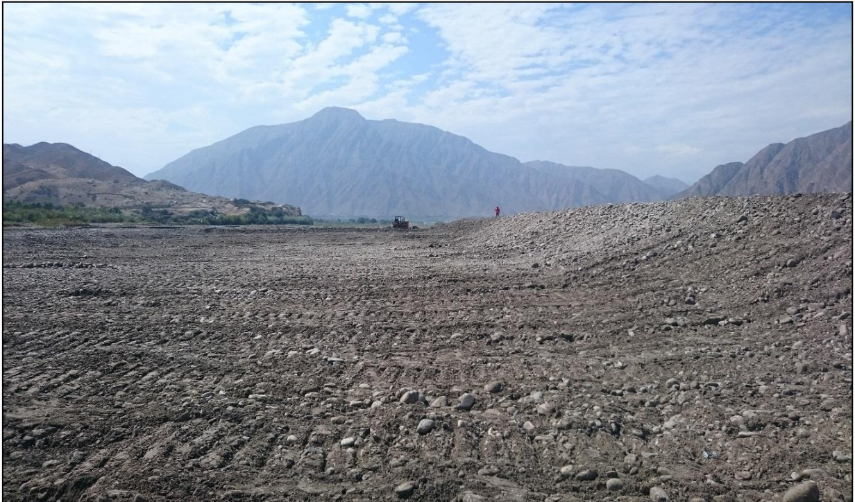
FOTO 15: se muestra una de las actividades de Prevención 2015-2016, Descolmatación del cauce del río Chicama, sector la Botella Pampas, terminado.
