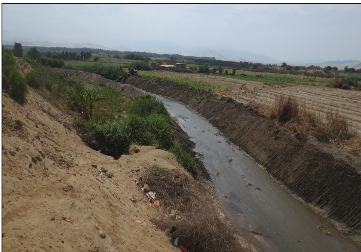
FOTO 32: se muestra una de las actividades de Prevención 2015-2016, Descolmatación y encauzamiento del río Huamanzaña, sector El Rosario, Terminado.
