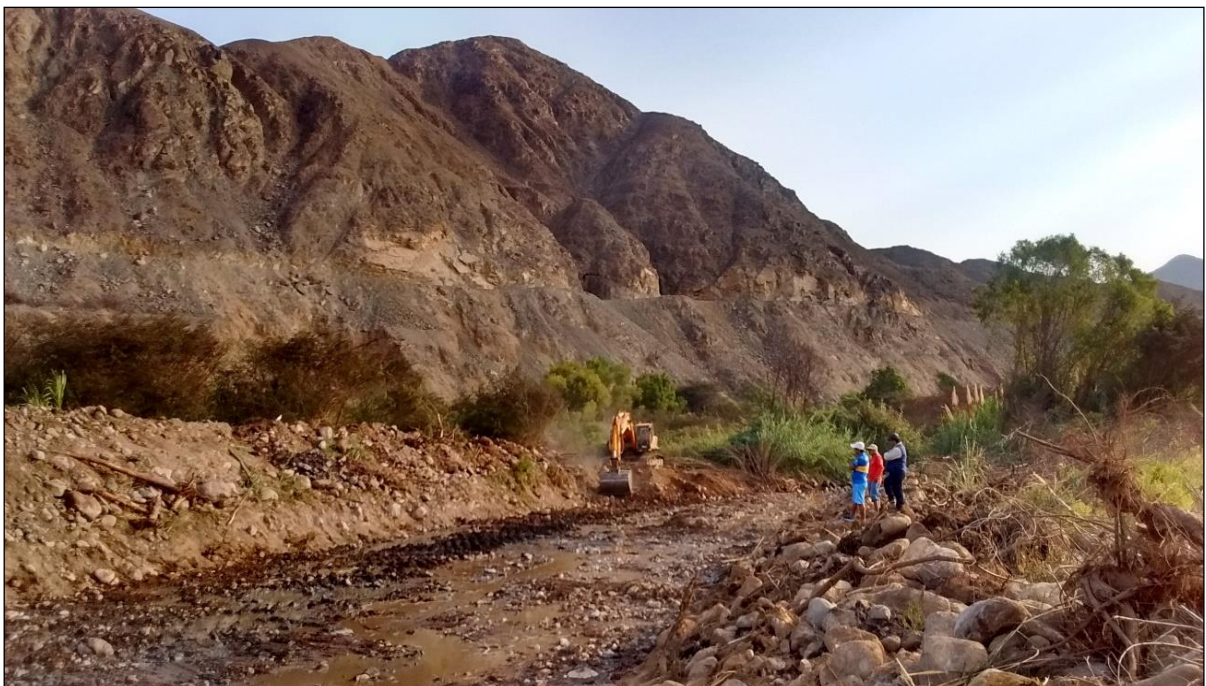
FOTO 22: se muestra una de las actividades de Prevención 2015-2016 en río Virú, tramo toma Choloque, Sector el Niño, durante su ejecución (Terminado)
