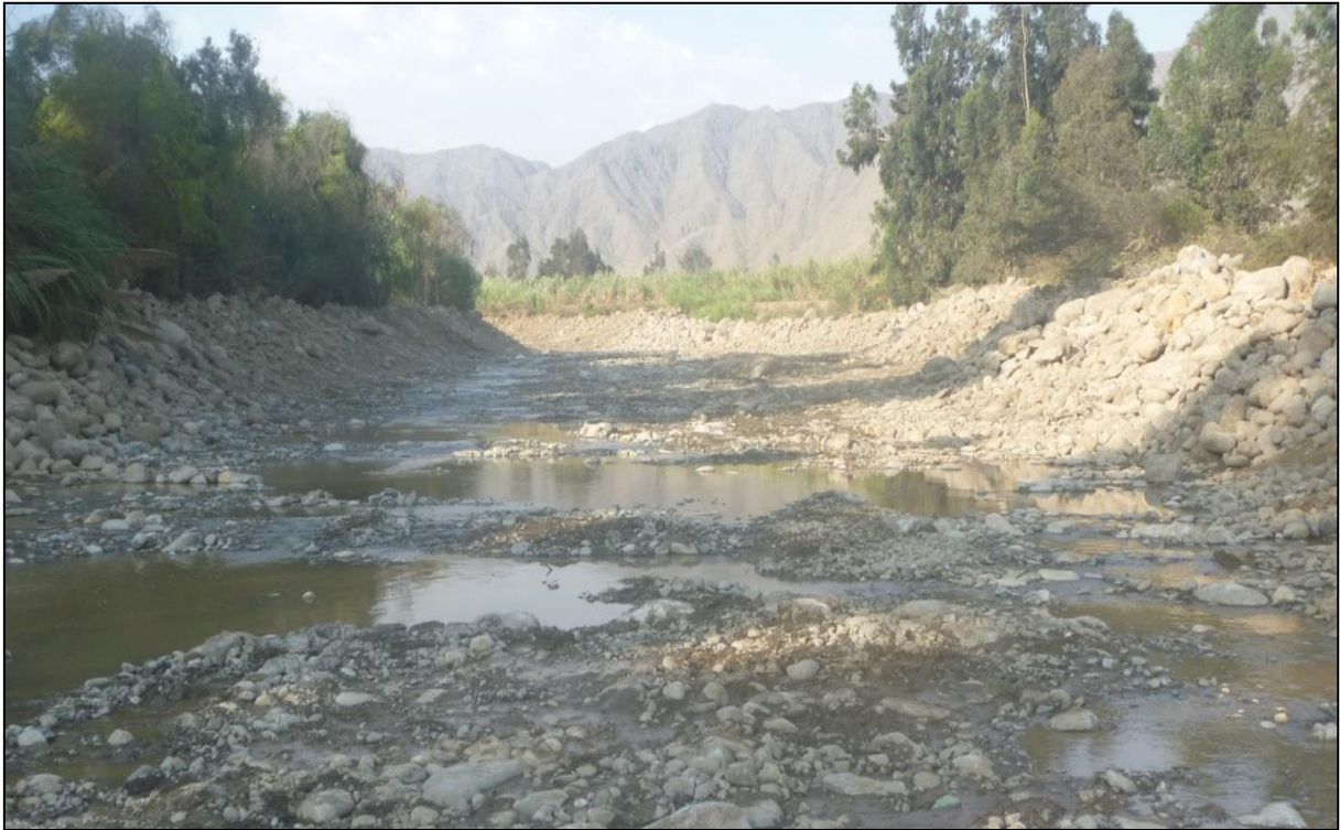
FOTO 45: se muestra una de las actividades de Prevención 2015-2016, Descolmatación de la margen derecha del río Moche, sector Santa Rosa Baja, Terminado.
