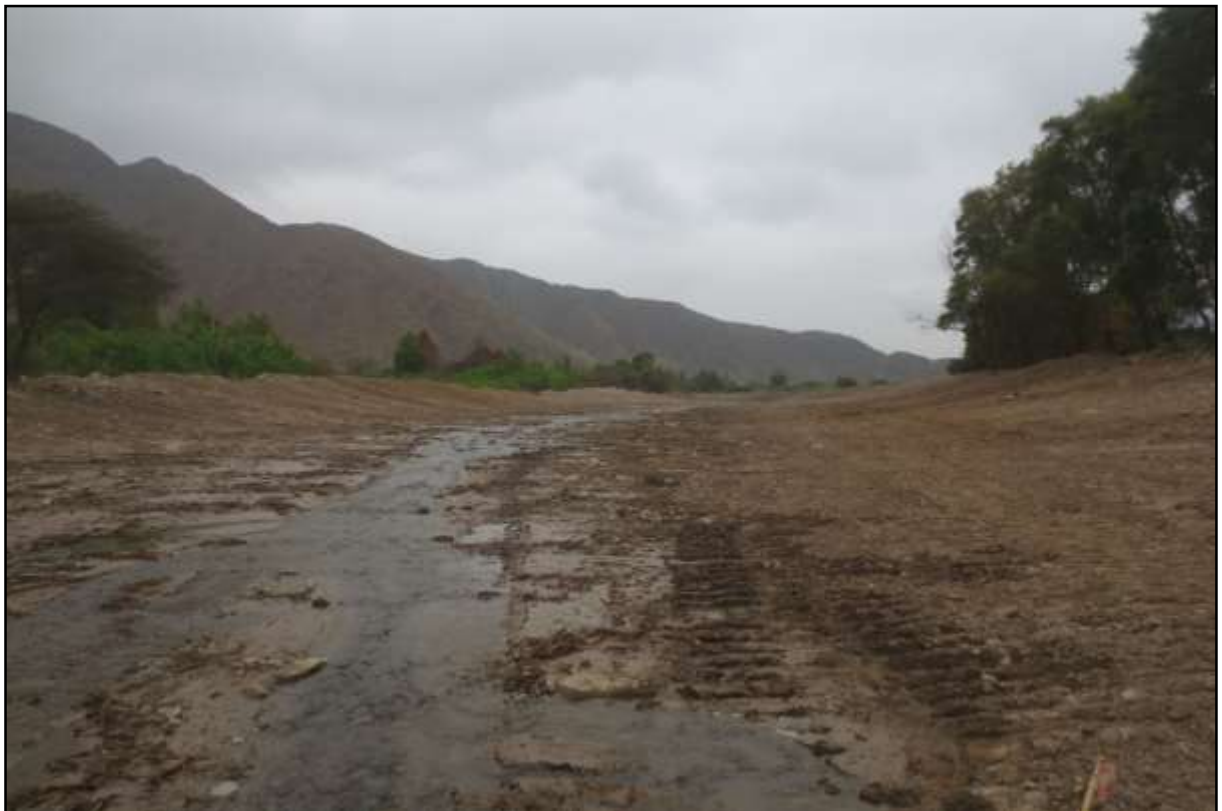
FOTO 24: se muestra una de las actividades de Prevención 2015-2016 en río Virú, tramo Enrique Toro, Sector Tomabal, Terminado.
