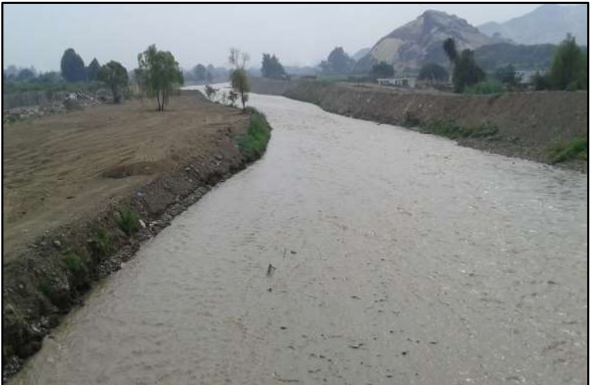
FOTO 52: Evaluación del comportamiento ante aumento del caudal en el río Moche, sector - Santa Lucia, fechas: 02-03/02/2016, donde los trabajos de descolmatación están respondiendo ante la crecida del río, no se ha evidenciado desbordes.
