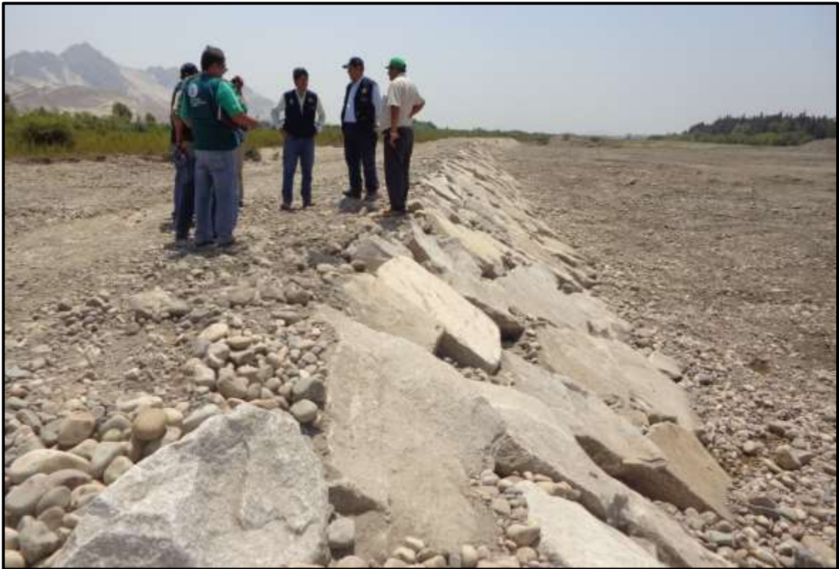
FOTO 19: se muestra una de las actividades de Prevención 2015-2016 en río Chicama, sector Alayo, Terminado.
