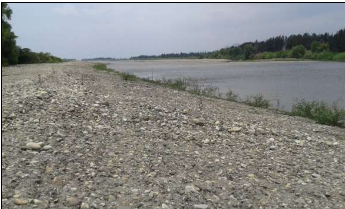
FOTO 47: Evaluación del comportamiento ante aumento del caudal en el río Chicama, sector Voladero, fechas: 02-03/02/2016, donde los trabajos de descolmatación están respondiendo ante la crecida del río, no se ha evidenciado desbordes.
