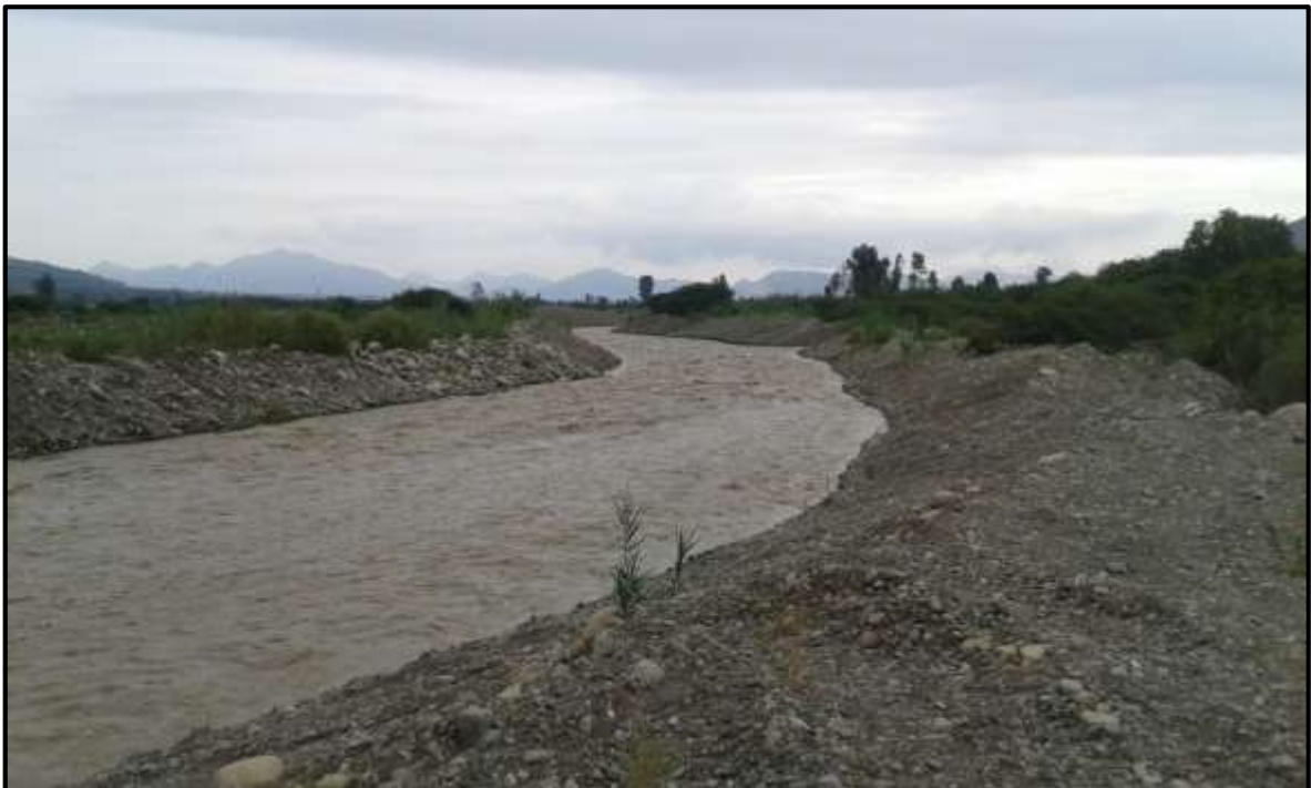
FOTO 54: Evaluación del comportamiento ante aumento del caudal en el río Virú, sector el Niño, fechas: 02-03/02/2016, donde los trabajos de descolmatación están respondiendo ante la crecida del río, no se ha evidenciado desbordes.
