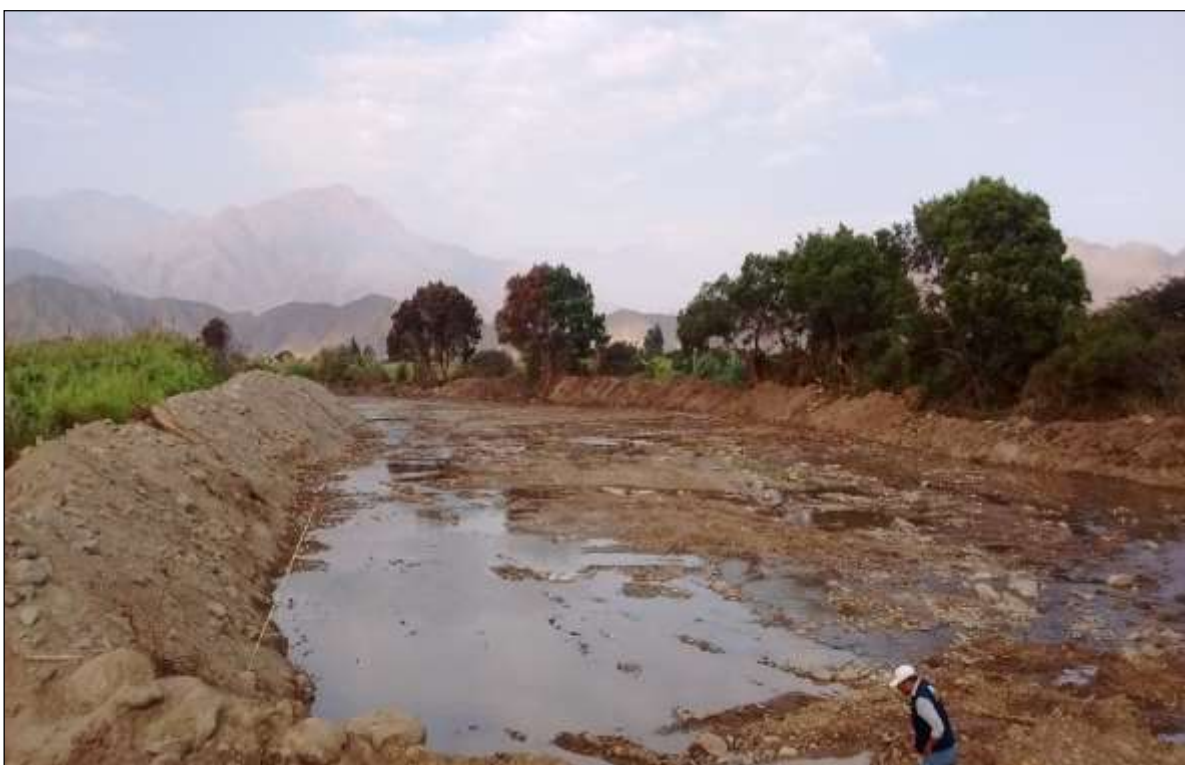
FOTO 28: se muestra una de las actividades de Prevención 2015-2016 en río Virú, tramo San Idelfonso, Sector la Gloria, Terminado.
