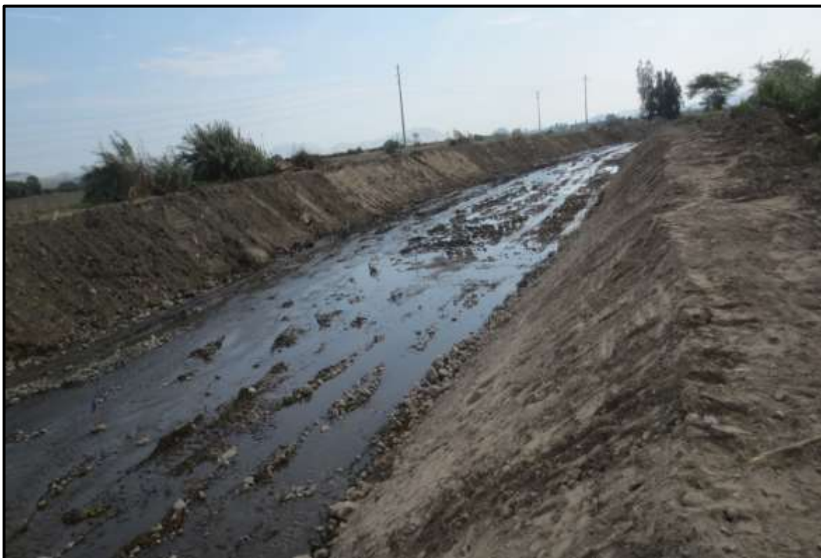
FOTO 59: se muestra una de las actividades de Prevención 2015-2016 III Paquete, Descolmatación y Encauzamiento del Río Huamanzaña, Sector Palermo., Terminado.
