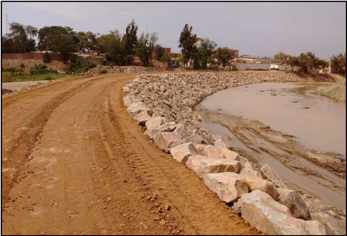
FOTO 55: se muestra una de las actividades de Prevención 2015-2016 III Paquete, Protección con Roca al Volteo, Margen Izquierda del Río Chaman, Sector Pueblo Nuevo, Terminado.
