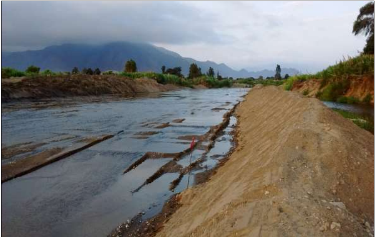
FOTO 29: se muestra una de las actividades de Prevención 2015-2016 en río Virú, tramo Serafin de la Cruz, Sector Santa Elena, Terminado.
