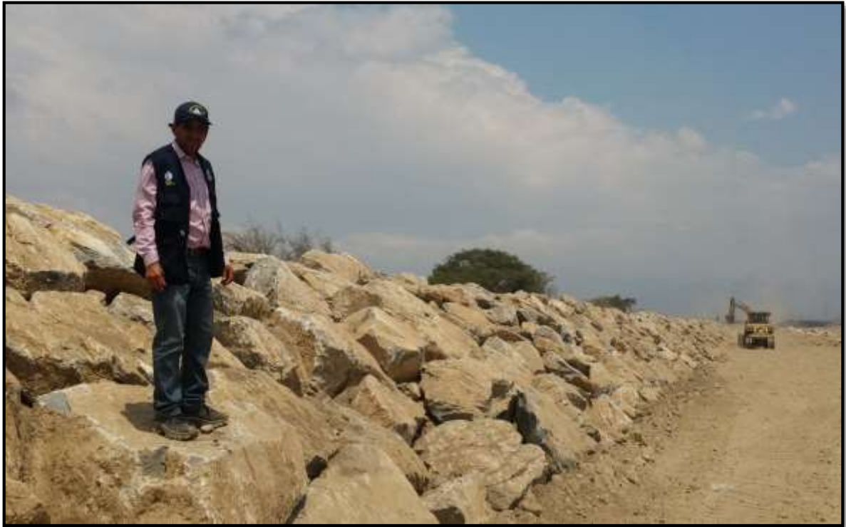
FOTO 65: se muestra una de las actividades de Prevención 2015-2016 Adicional I Paquete, Limpieza, Descolmatación y Protección del cauce del río Chaman, Sector Huaca Blanca Alta, Distrito de Pacanga-Chepen-La Libertad, Terminado.
