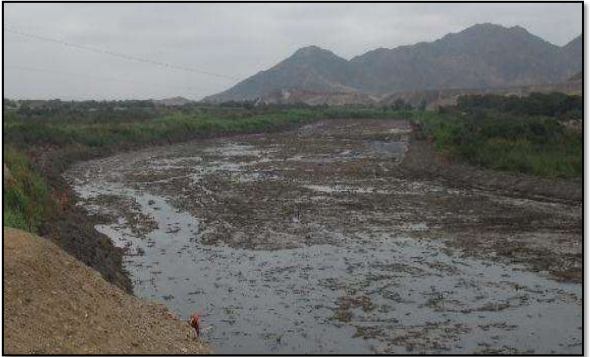
FOTO 07: se muestra una de las actividades de Prevención 2015-2016 en río Chaman, sector Tahuantinsuyo, terminado.
