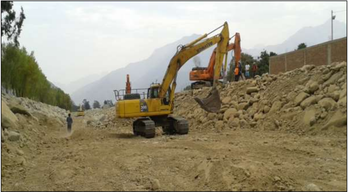
FOTO 37: se muestra una de las actividades de Prevención 2015-2016 en río Pedregal-Simbal, Terminado.
