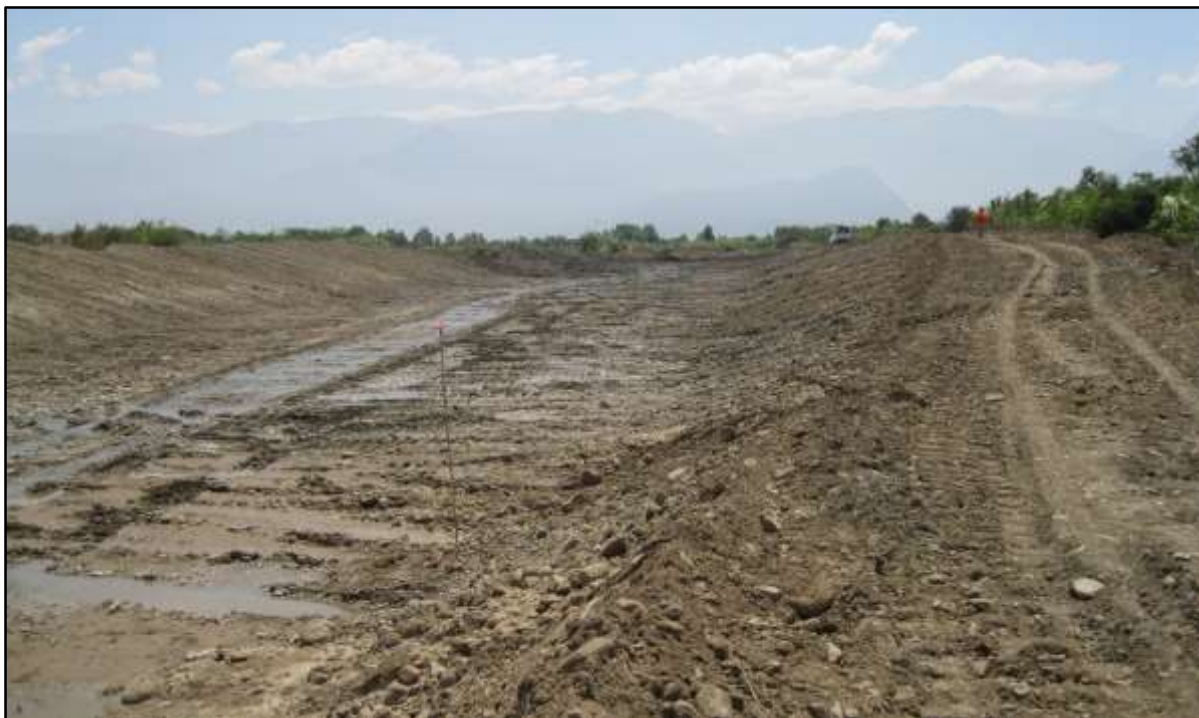
FOTO 33: se muestra una de las actividades de Prevención 2015-2016, Descolmatación y Encausamiento del rio Chorobal, sector San Roberto, Terminado.
