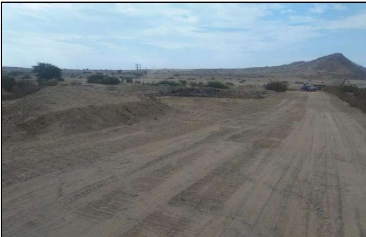
FOTO 62: se muestra una de las actividades de Prevención 2015-2016 Adicional I Paquete, Defensa Margen Derecha Canal Talambo Zaña Km: 24+552 - 31+315, Terminado.
