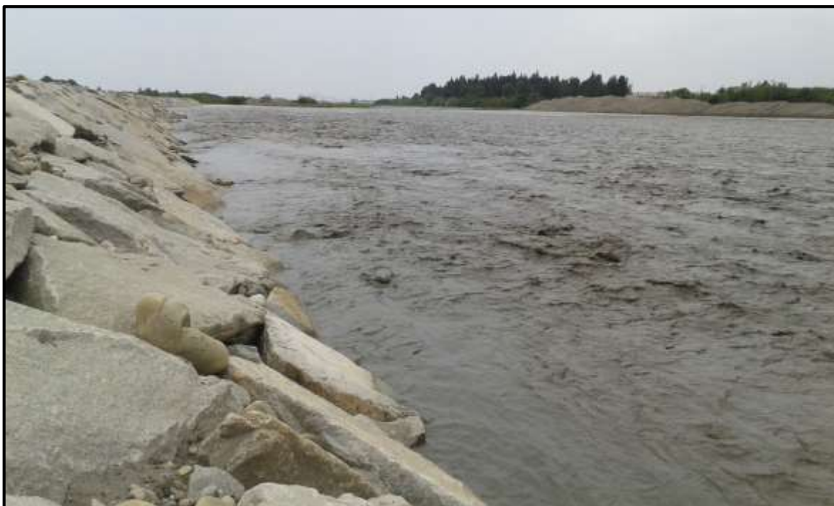
FOTO 48: Evaluación del comportamiento ante aumento del caudal en el río Chicama, sector Atahualpa, fechas: 02-03/02/2016, donde el dique con protección de roca acomodada en el talud húmedo, están respondiendo ante la crecida del río, no se ha evidenciado desbordes.
