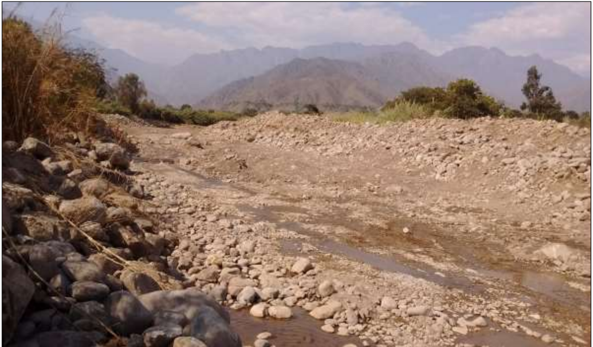
FOTO 21: se muestra una de las actividades de Prevención 2015-2016 en río Virú, tramo toma Benítes, Sector Huacapongo, terminado
