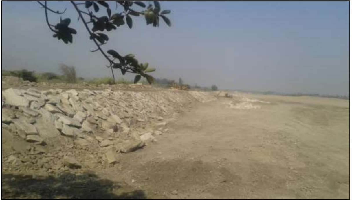
FOTO 11: se muestra una de las actividades de Prevención 2015-2016 en el río Chicama, sector Bocatoma Paijan Viejo, Terminado.
