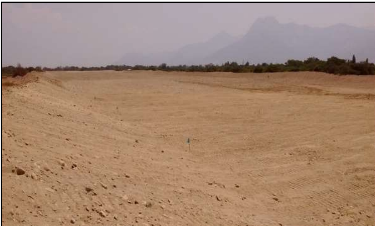
FOTO 64: se muestra una de las actividades de Prevención 2015-2016 Adicional I Paquete, Limpieza y Descolmatación del cauce del río Chaman, Sector Huaca Blanca baja, Distrito de Pacanga - Chepen- la Libertad, Terminado.
