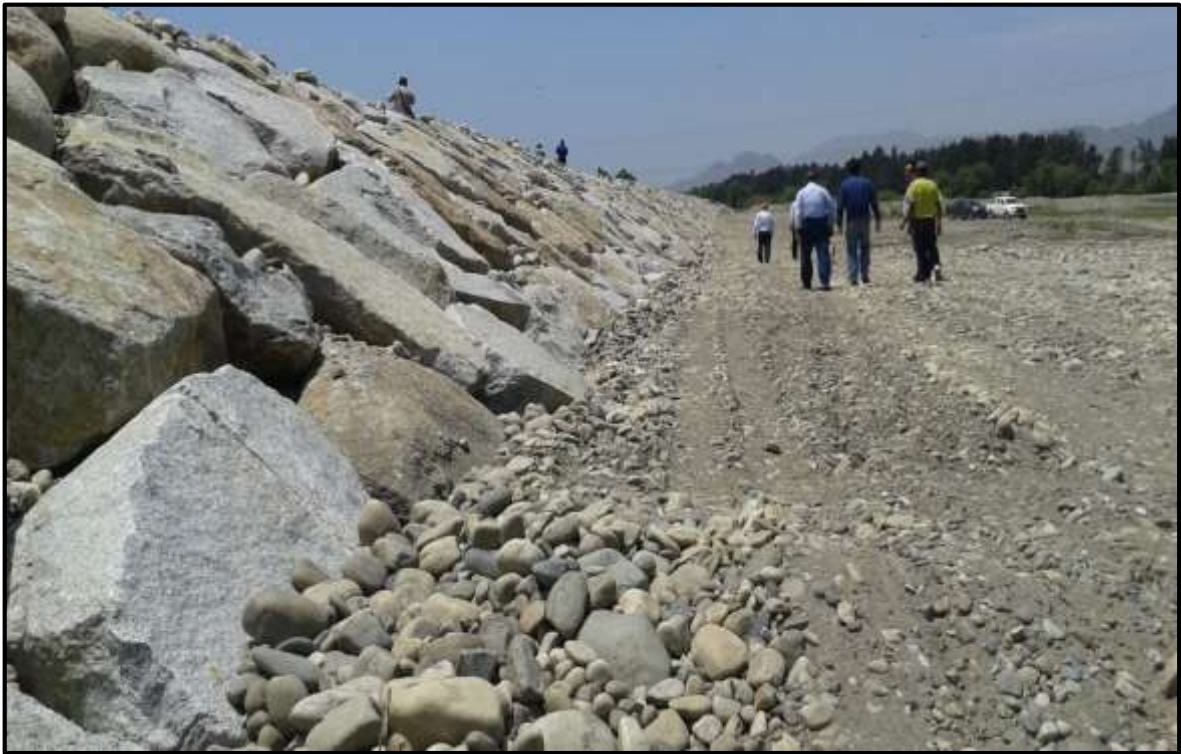
FOTO 67: se muestra una de las actividades de Prevención 2015-2016 Adicional I Paquete, Protección con roca al volteo en el río Chicama, Sector Voladero - Atahualpa, Terminado.
