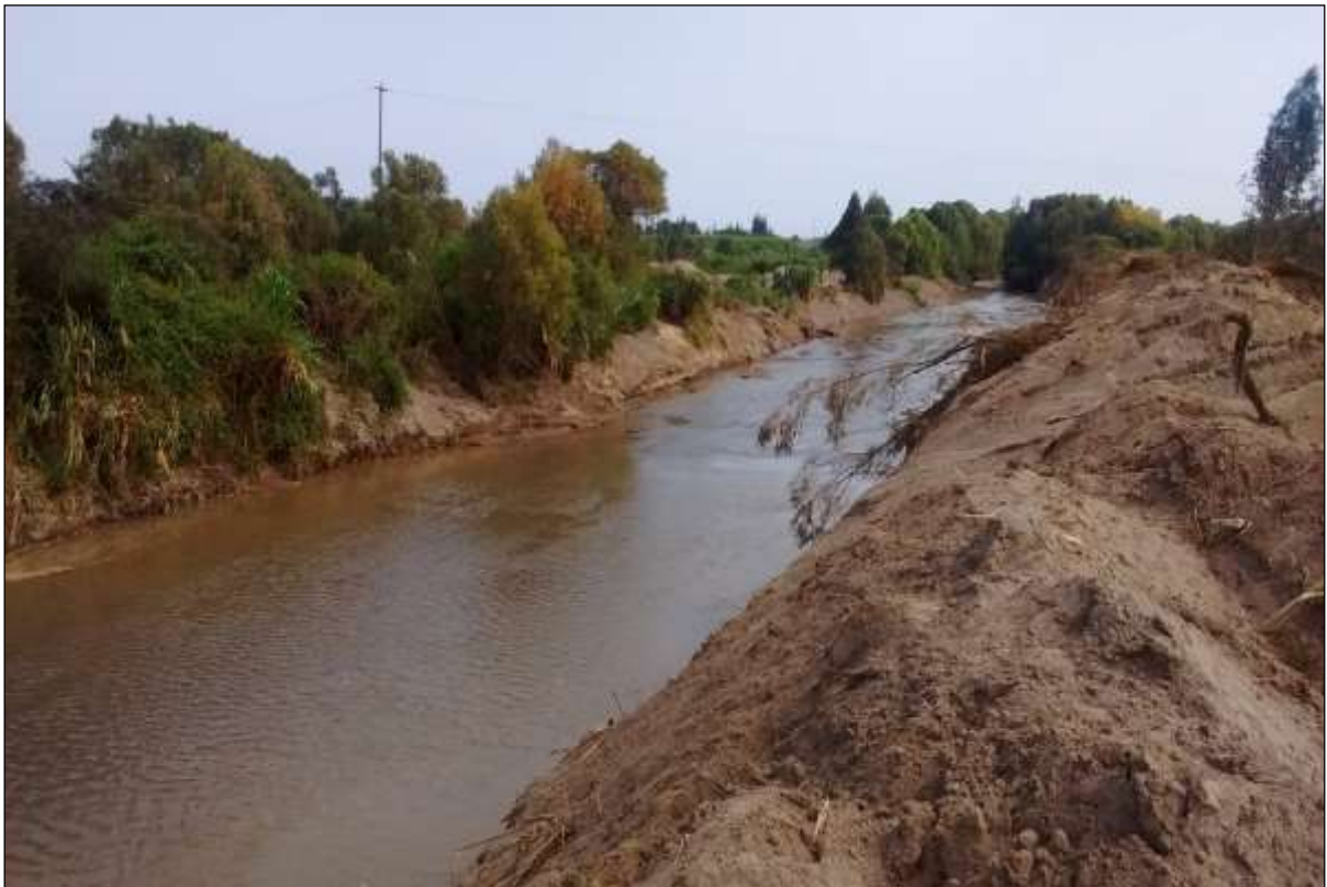
FOTO 30: se muestra una de las actividades de Prevención 2015-2016 en río Virú, tramo Huancaquito Bajo, Sector Huancaquito Bajo, Terminado.
