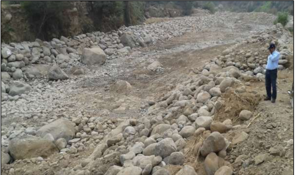
FOTO 39: se muestra una de las actividades de Prevención 2015-2016, Descolmatación protección del río Moche, sector La Tranca - Puente Poroto, Terminado
