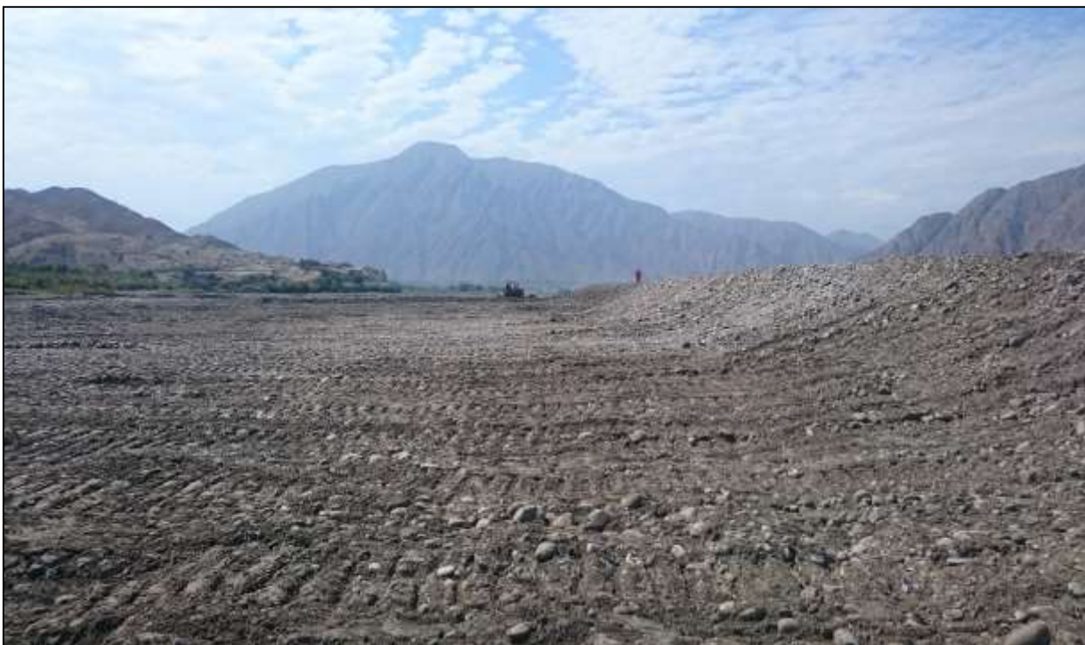
FOTO 15: se muestra una de las actividades de Prevención 2015-2016, Descolmatación del cauce del río Chicama, sector la Botella Pampas, terminado.
