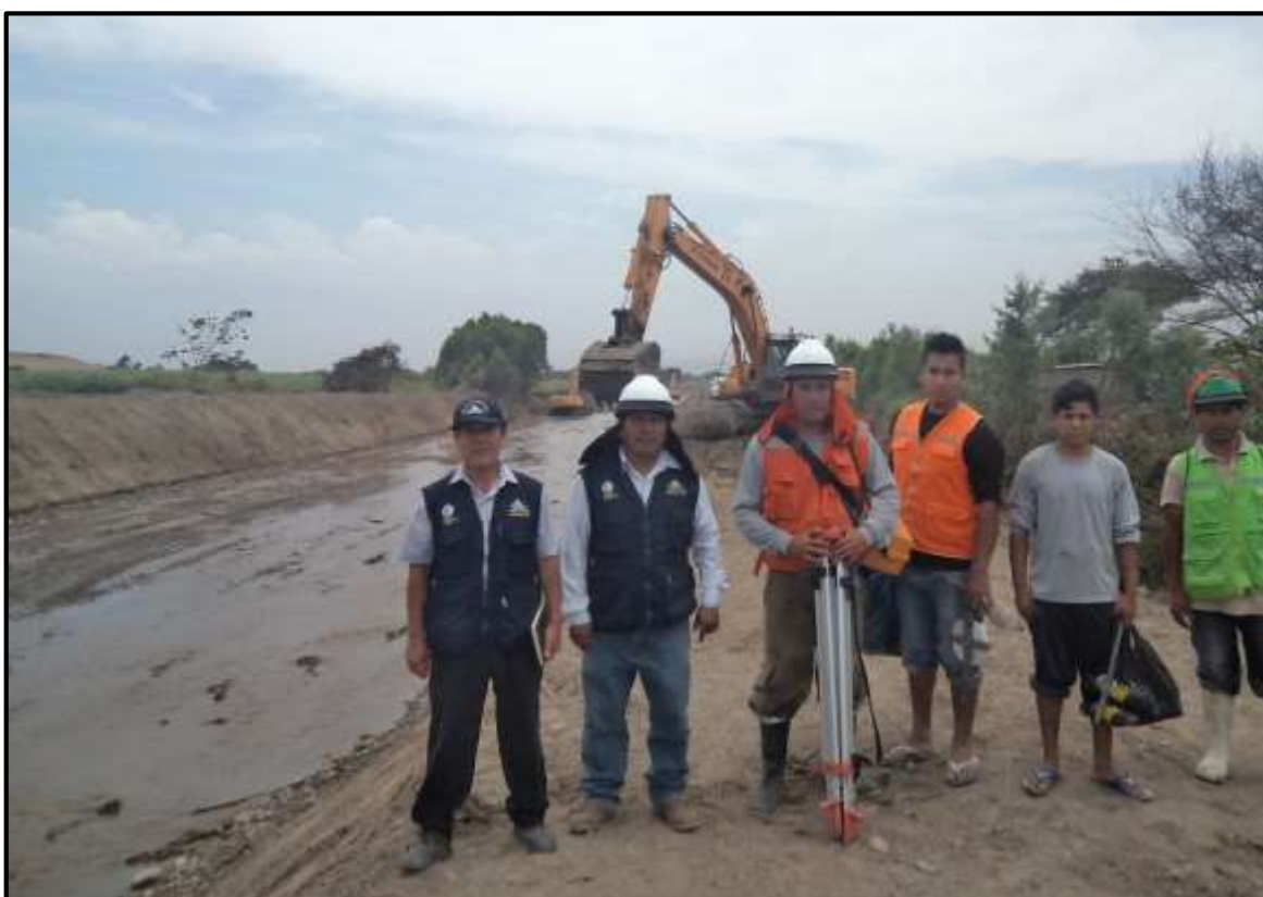
FOTO 58: se muestra una de las actividades de Prevención 2015-2016 III Paquete, Descolmatación y Encauzamiento del Río Chorobal, Sector El Inca, Terminado.
