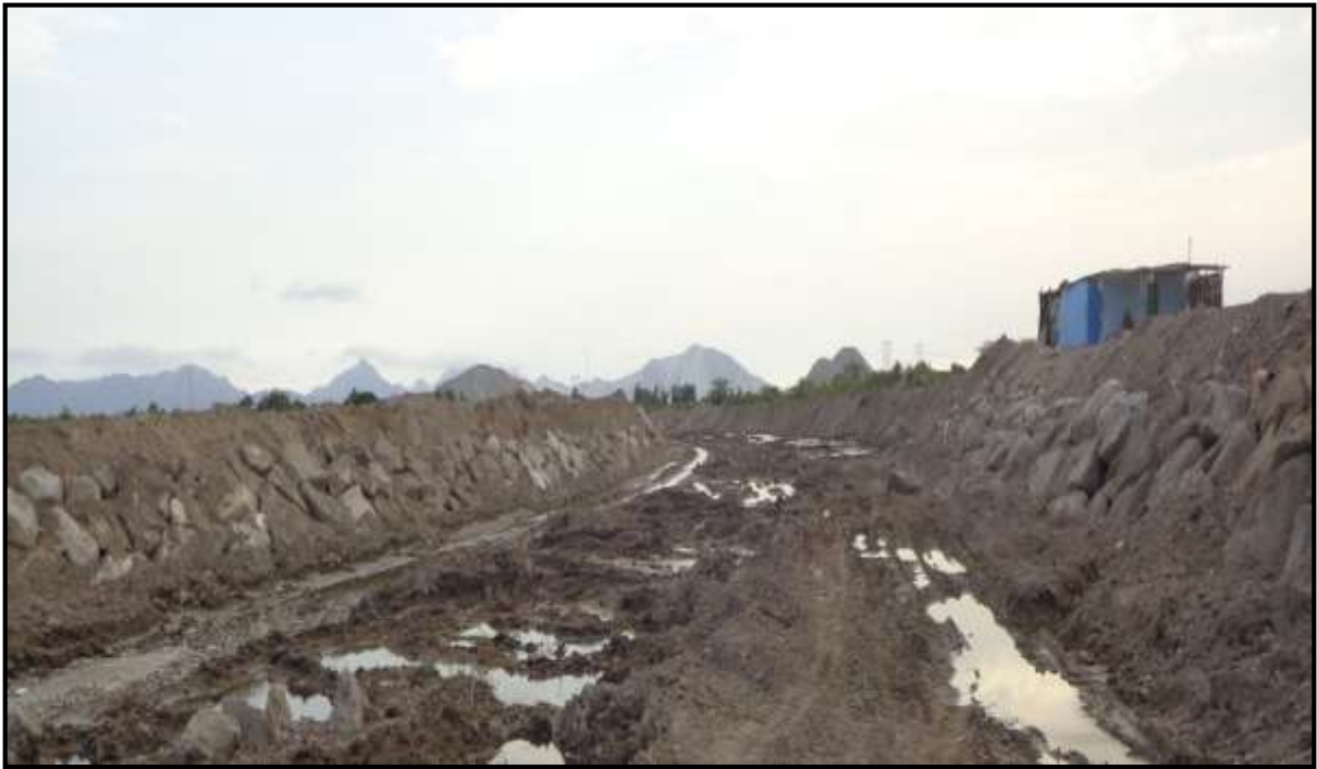
FOTO 31: se muestra una de las actividades de Prevención 2015-2016, Protección con roca ambas márgenes río Huamanzaña, sector San Carlos, Terminado.
