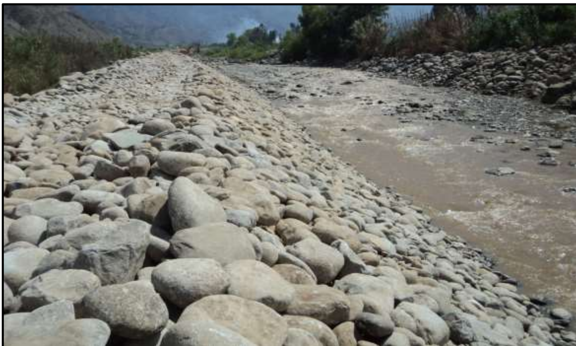
FOTO 57: se muestra una de las actividades de Prevención 2015-2016 III Paquete, Descolmatación del Río Moche, Sector Mochal, Terminado.
