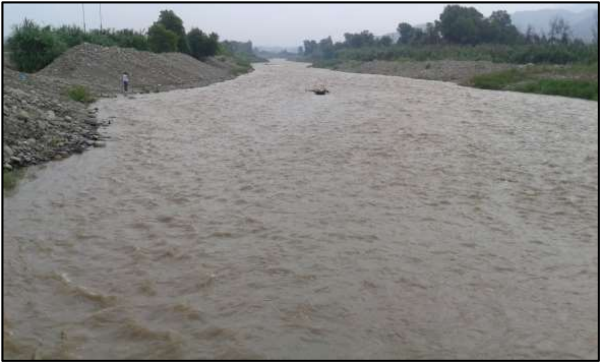
FOTO 51: Evaluación del comportamiento ante aumento del caudal en el río Moche, sector toma santo Domingo, fechas: 02-03/02/2016, donde los trabajos de descolmatación están respondiendo ante la crecida del río, no se ha evidenciado desbordes.
