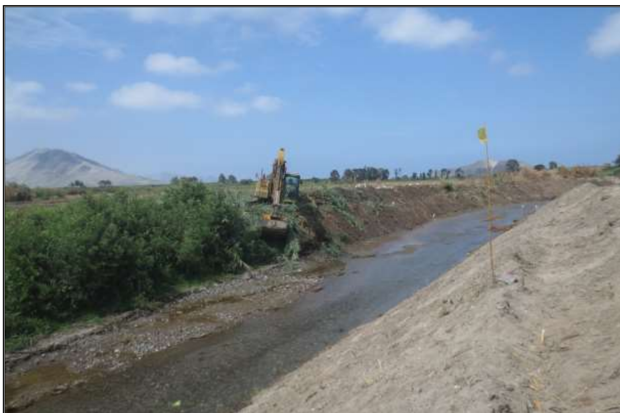
FOTO 36: se muestra una de las actividades de Prevención 2015-2016, Descolmatación y Encausamiento del río Chao, sector las delicias, Terminado.
