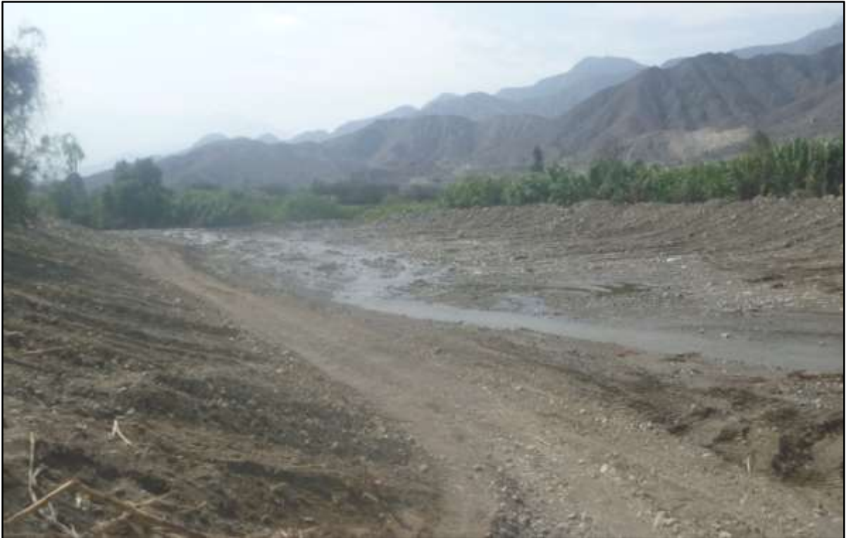
FOTO 41: se muestra una de las actividades de Prevención 2015-2016, Descolmatación y protección de la margen izquierda del río Moche, sector Bocatoma Santo Domingo, Terminado.
