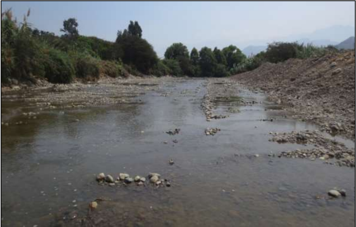
FOTO 25: se muestra una de las actividades de Prevención 2015-2016 en río Virú, tramo Gaspar Abanto, Sector Zaraqe, Terminado.
