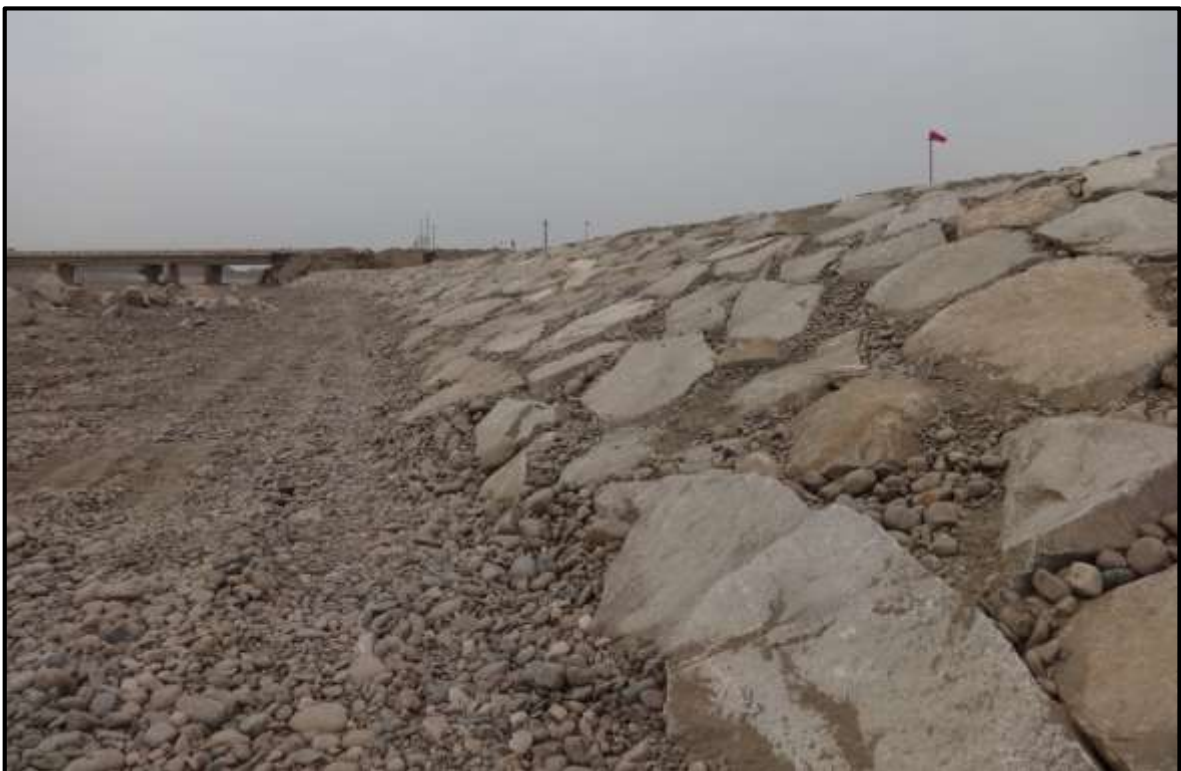
FOTO 56: se muestra una de las actividades de Prevención 2015-2016 III Paquete, Descolmatación del Río Chicama Aguas Arriba del Puente Careaga, terminado.
