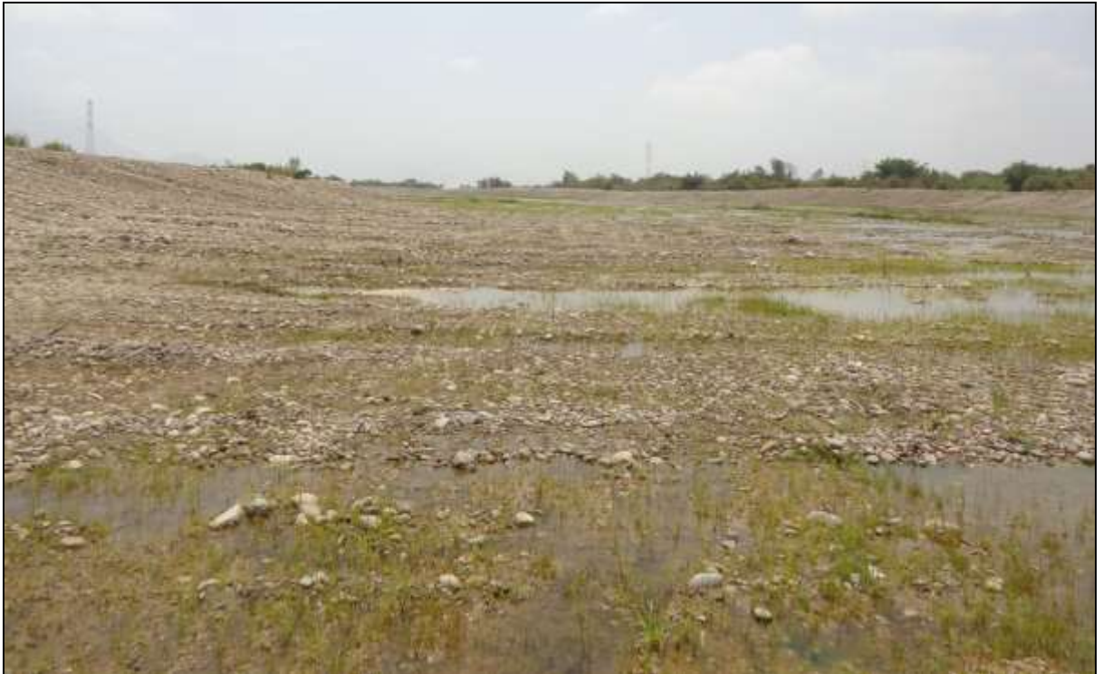
FOTO 03: se muestra una de las actividades de Prevención 2015-2016 en rio Jequetepeque, sector Infiernillo de Cultambo, terminado.
