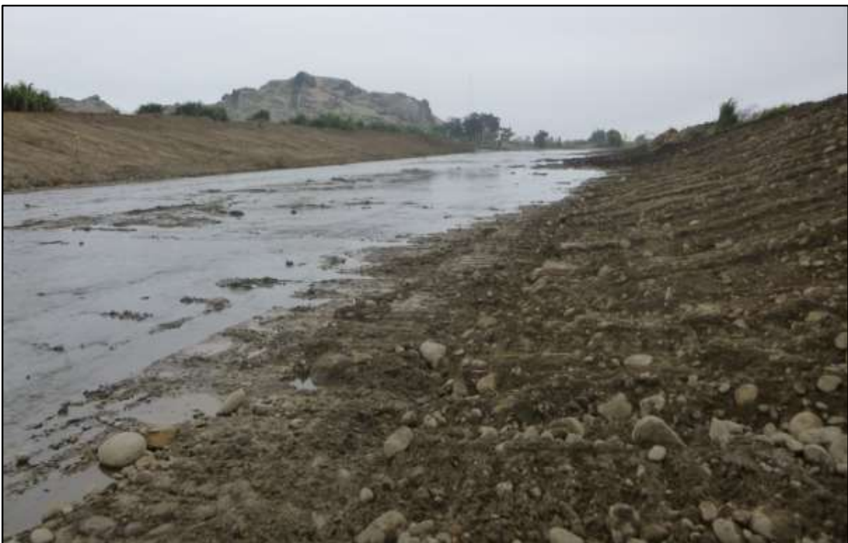
FOTO 38: se muestra una de las actividades de Prevención 2015-2016, Descolmatación protección del río Moche M.I., sector Puente Moche - Laguna de Estabilización Curva Sun - Toma Arenal Sánchez ( Santa Lucía ), Terminado
