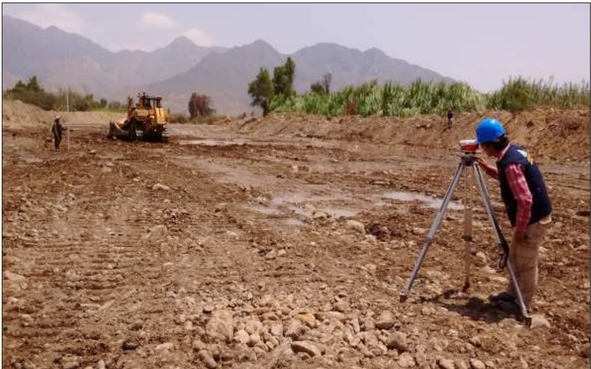
FOTO 26: se muestra una de las actividades de Prevención 2015-2016 en río Virú, tramo toma San Nicolás, Sector San Nicolás, Terminado.
